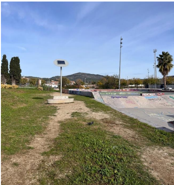
Llumenera amb panel fotovoltaic i banc de formigó a retirar
