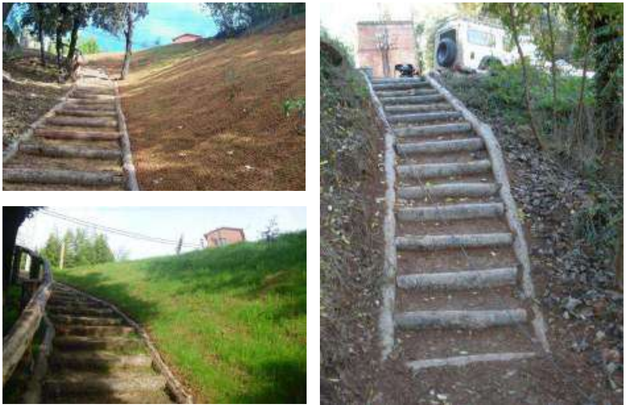
Figura 2 Exemple d'esglaons de fusta de castanyer (executades per l'empresa Naturalea)
