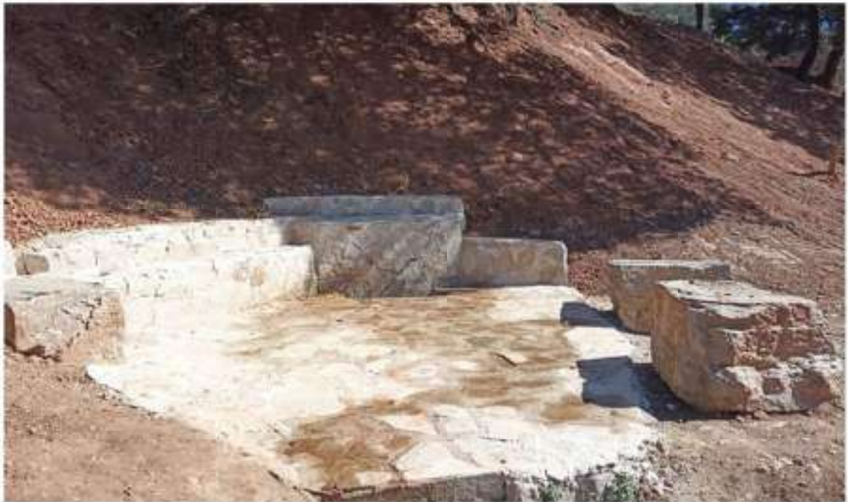
Figura 1 Exemple empedrat executat a la font de les Canyes
