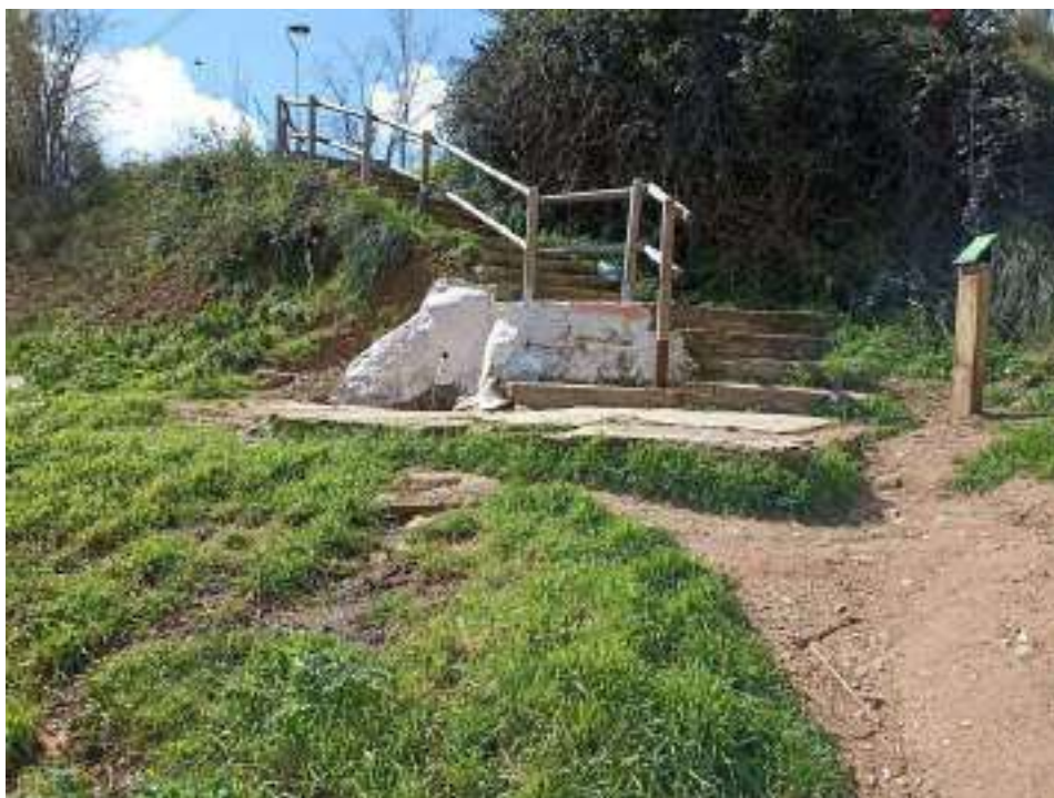
Aspecte actual de la font de la Grípia
