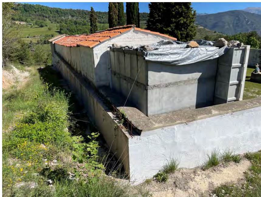
Imatge 09: Estat actual. Actuacions a la fase 2, prolongament del mur de contenció del trasdós dels nínxols al cos de ponent i execució de nous nínxols i columbari.
