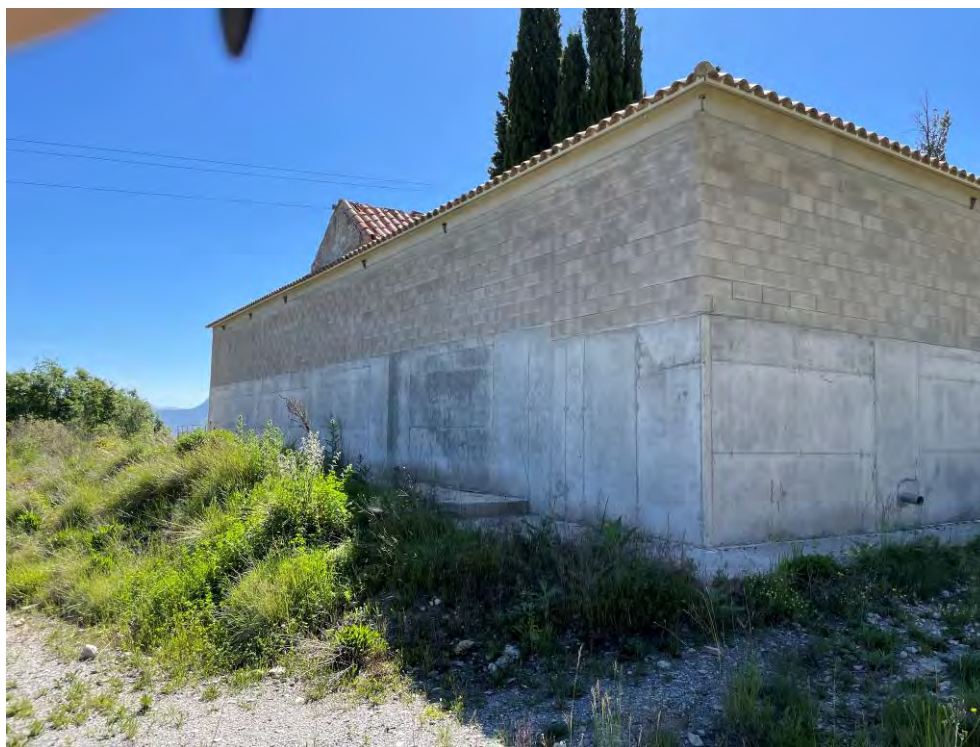
Imatge 07: Estat actual. Vista exterior del mur de contenció executat a la fase 1 a la façana nord per a sosteniment dels nínxols i de la vesant exterior de la coberta.
