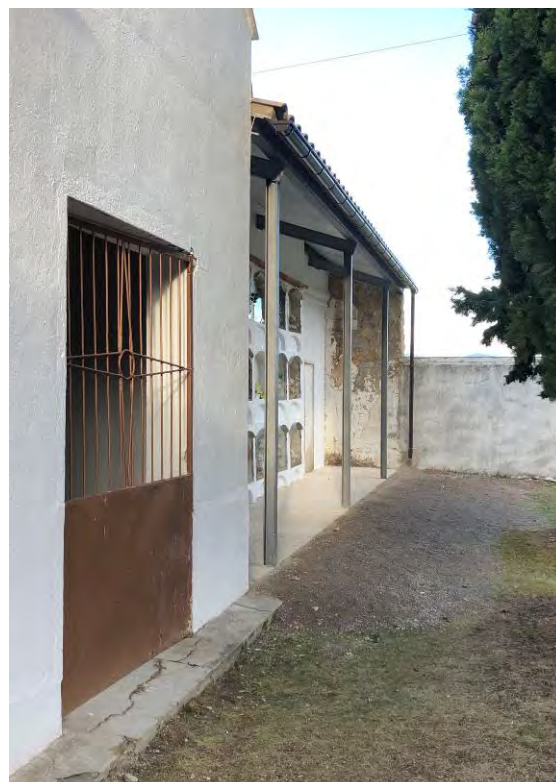
Imatges 05 i 06: Estat actual. Vistes de la coberta executada a la fase 1(2018) A l'esquerra la cantonada nord oest i a la dreta el costat de llevant. Es va retirar les teules de l'anterior coberta i se'n va executar una de nova sobre estructura metàlica i panellat. Model de coberta a replicar.
