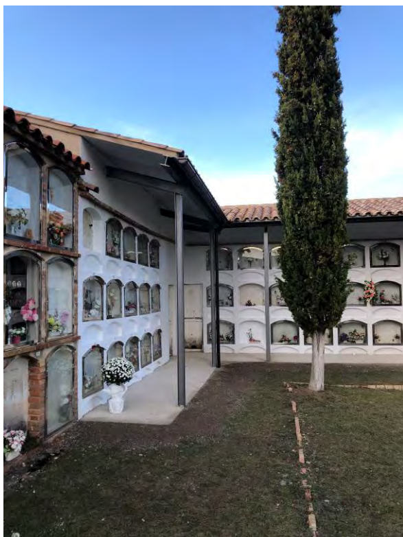
Imatges 05 i 06: Estat actual. Vistes de la coberta executada a la fase 1(2018) A l'esquerra la cantonada nord oest i a la dreta el costat de llevant. Es va retirar les teules de l'anterior coberta i se'n va executar una de nova sobre estructura metàlica i panellat. Model de coberta a replicar.
