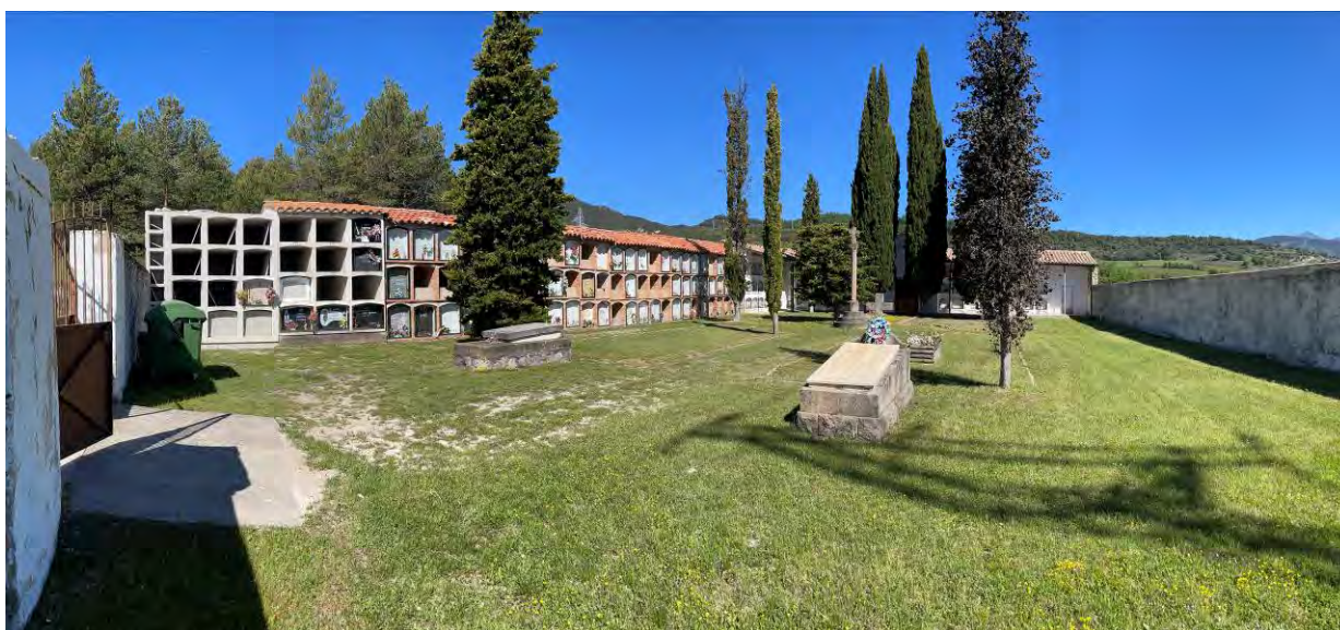
Imatge 04: Estat actual. Vista interior del cementiri en l'estat actual on es pot veure el nou annex sud de nínxols executat a la fase 2 i que requereix, juntament a la resta d'aquest cos d'una coberta nova.
