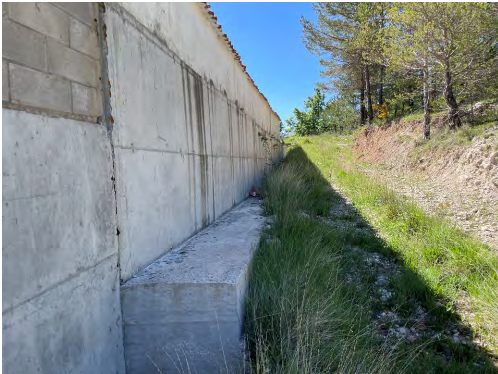
Imatge 08: Fase 2 Continuació del mur de contenció de trasdós a la façana exterior de ponent de la fase 1.
