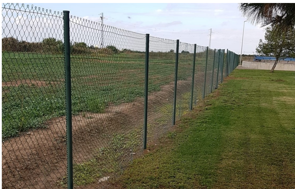
Fig.4. Tanca sud actual depuradora Tàrrega
