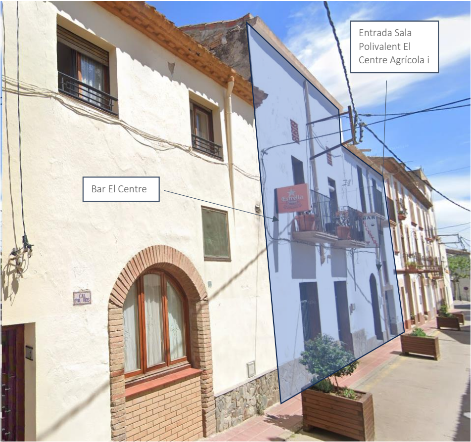
Figura 2.4. Vista del local i finques d'habitatges veïns (a dreta i esquerra)
