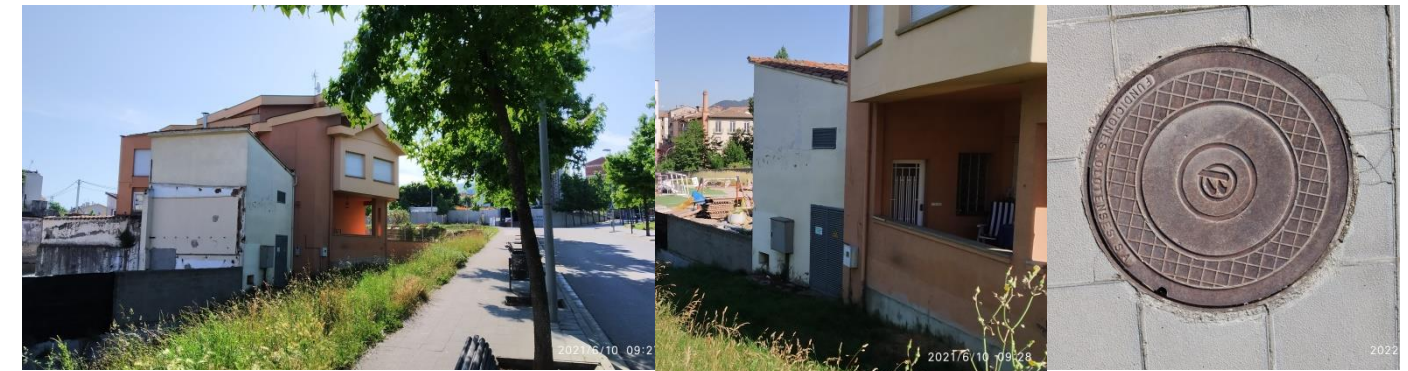
Estació transformadora situada al carrer Folch i Torres
