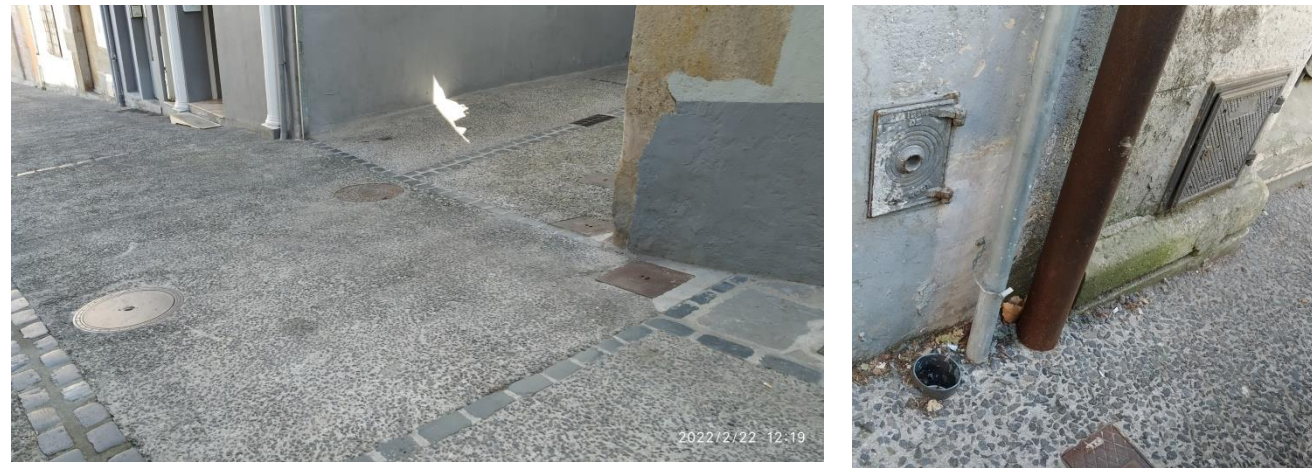
c/Sant Cristòfor: entroncament amb c/Pardal i connexió aigües pluvials
