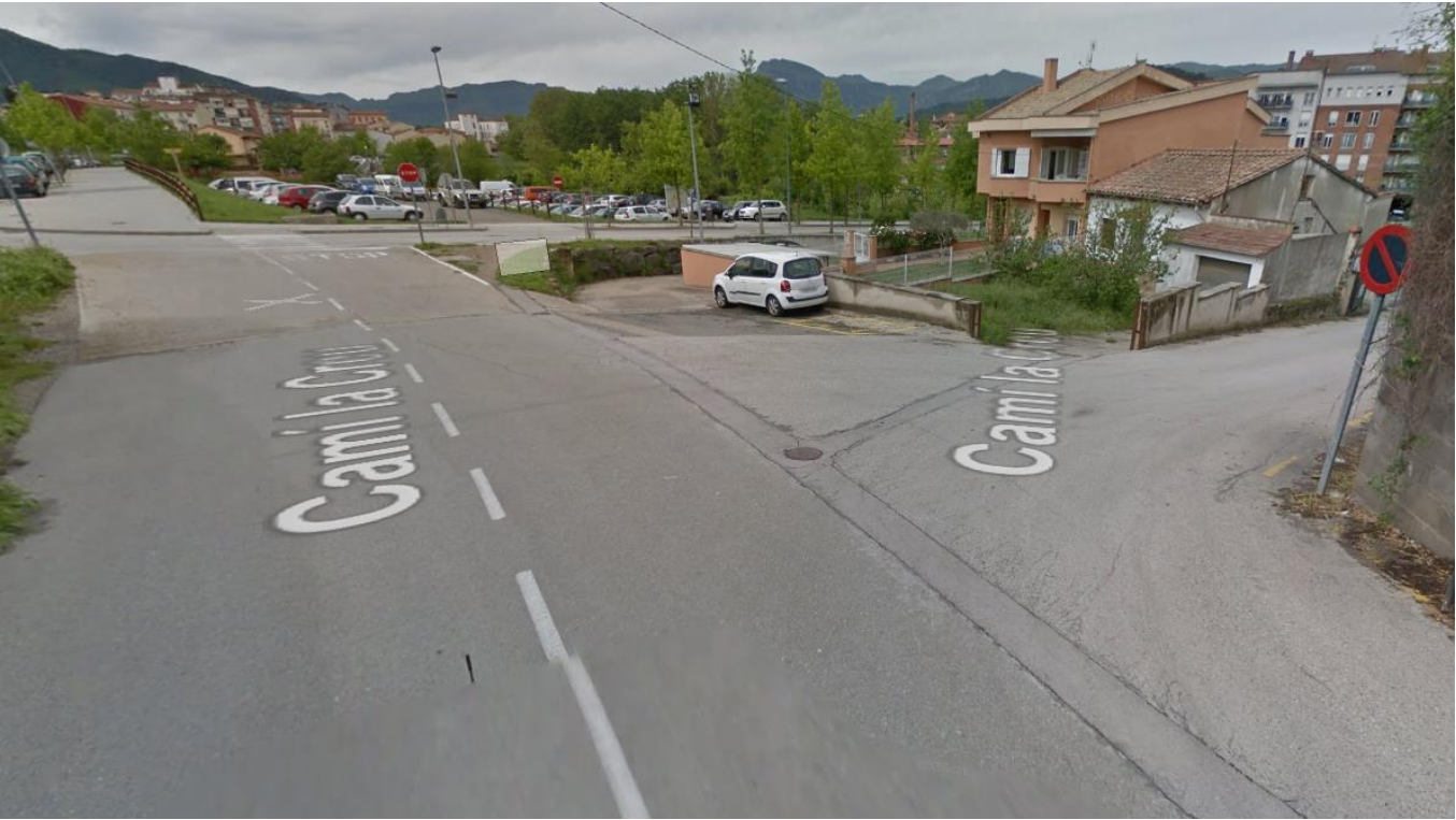
En aquesta foto, prèvia a les obres de reurbanització, s’observa la traça que seguia i manté la canonada d’aigua (Font: Google Maps)
