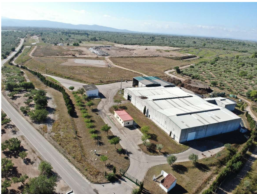
Fig. 3.- Accés a la planta de compostatge, bàscula i oficines.
