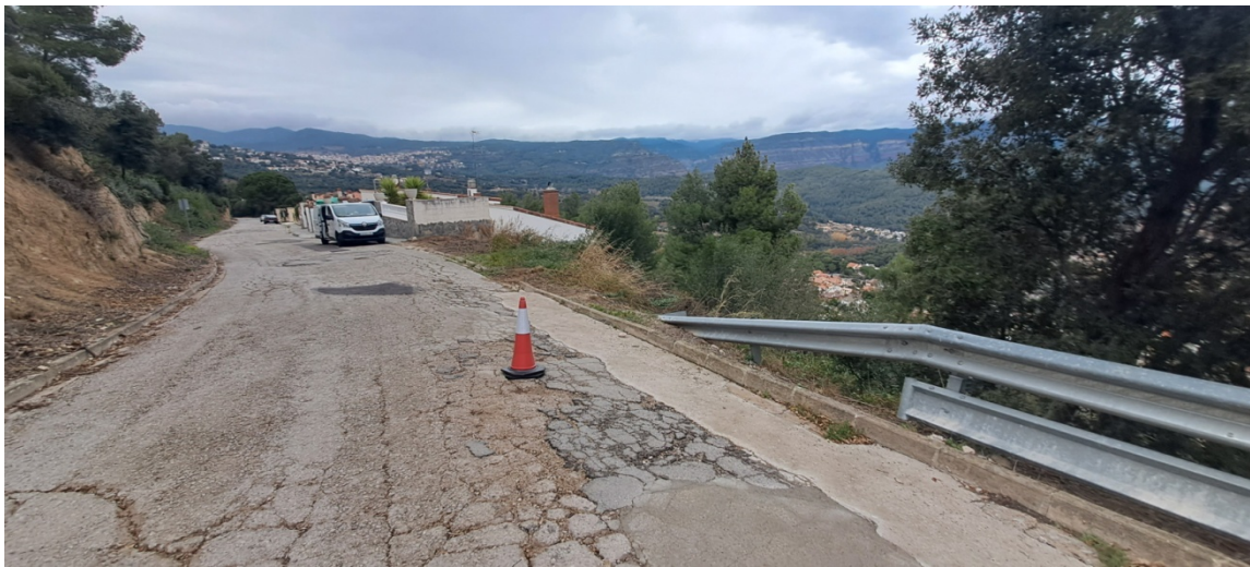
Fotografia 1. Vista general del sector nord de la zona d'estudi (fins furgoneta)
