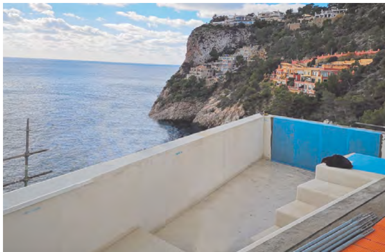
Colocar la BANDA-SOLAPES en todas las uniones LAMINA-LAMINA en el interior de las piscinas.
