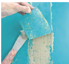
Aplicar EPOXICOL entre las LAMINAS para pegar la BANDA-SOLAPES .
