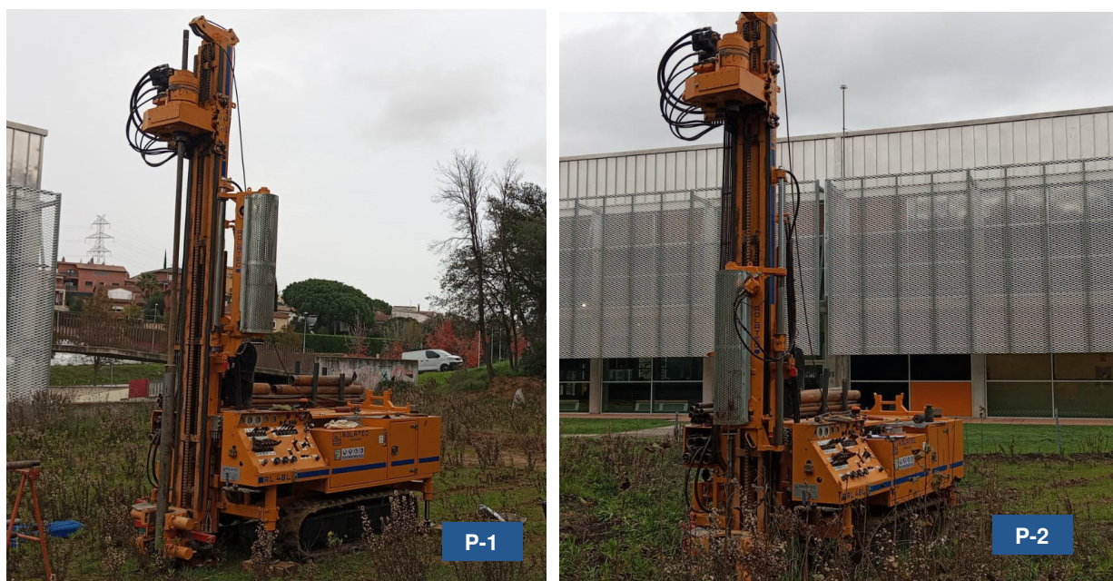
Figura 3. Execució dels DPSH P-1 i P-2.
