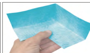
Colocar la BANDA-ESQUINAS en todos los ángulos de 90° de la piscina o terraza.
