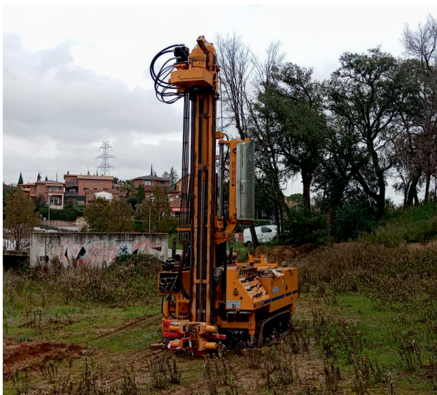
Fotografia 5. Execució del sondeig S-2R.
