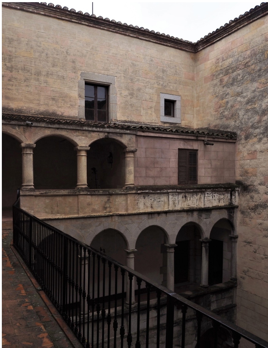
Cuerpo añadido sobre la logia original de piedra en la fachada Este del patio
