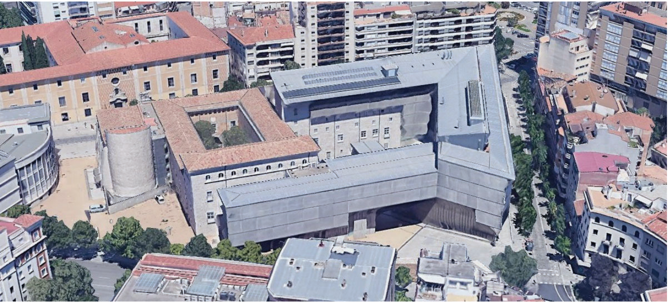
Vista de la coberta de l'edifici. A la dreta, coberta de xapa de zenc i a l'esquerra, coberta de teula.
