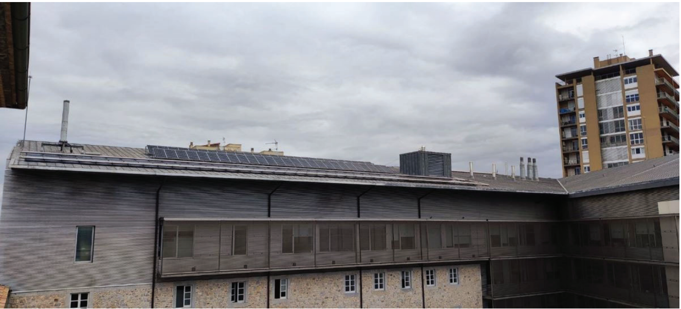
Vista de la coberta, objecte de la intervenció.
