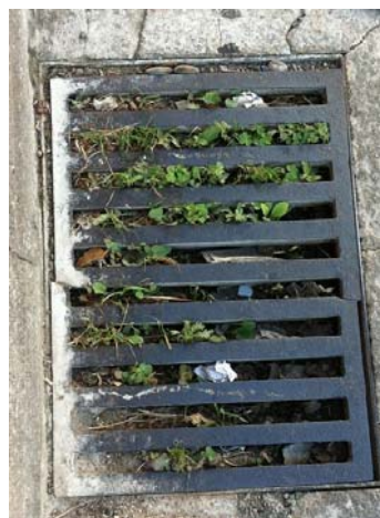
Fotografia A, B, C: Embornals inutilitzats. C/ De l'estació; Germà Agustí i pg. De Vilaret
