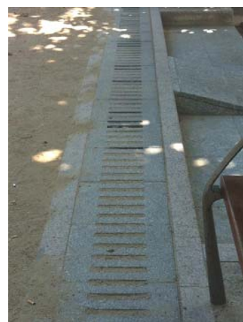
Fotografia A, B, C: Embornals inutilitzats. C/ De l'estació; Germà Agustí i pg. De Vilaret
