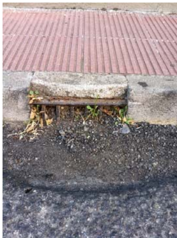
Fotografia A, B, C: Embornals inutilitzats. C/ De l'estació; Germà Agustí i pg. De Vilaret
