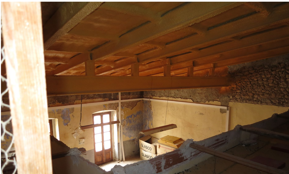
Estructura coberta de xapa
