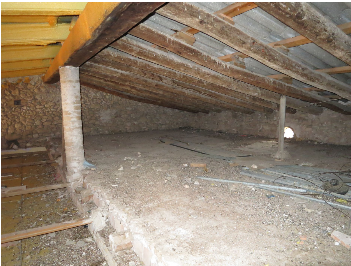
Estructura coberta de fibrociment
