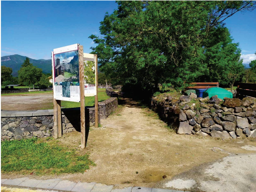
Foto 1: Inici actuació, EIX 1 - PK 0+000
