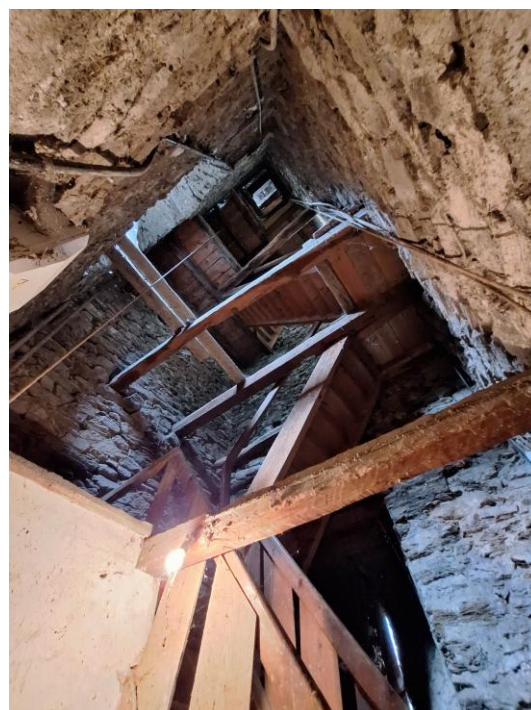
Entrada al ámbito de la torre del campanario desde la nave de la Iglesia, pisando un suelo en el que ya no existe tarima de madera, la cual se encuentra sobre tierra compacta directamente, así como el desarrollo de la escalera de madera entre los distintos niveles de la torre del campanario.
