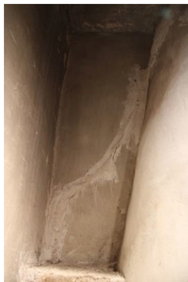
Recull d'imatges que exemplifiquen el pèssim estat de conservació que presenten els revestiments murals i les pintures de la cuina-menjador i les habitacions de la primera planta.
