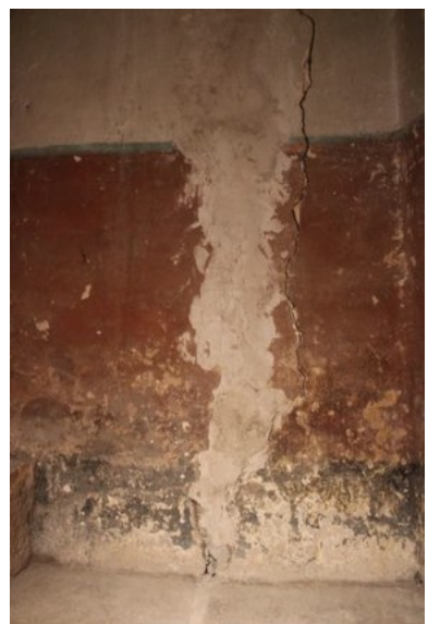
Recull d'imatges que exemplifiquen el pèssim estat de conservació que presenten els revestiments murals i les pintures de la cuina-menjador i les habitacions de la primera planta.
