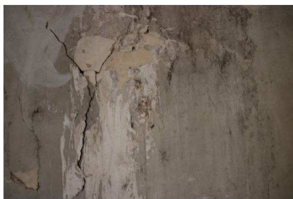
Detall de la brutícia endurida damunt la capa pictòrica a les parets del menjador.
