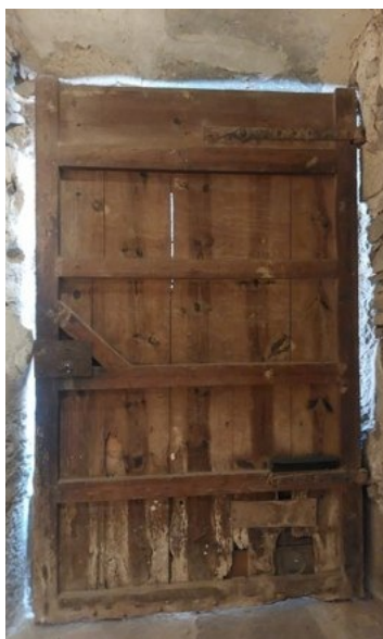
Porta d'entrada a l'habitatge. L'anvers acumula intervencions modernes com el repint de la superfície original i la protecció de la part inferior.
