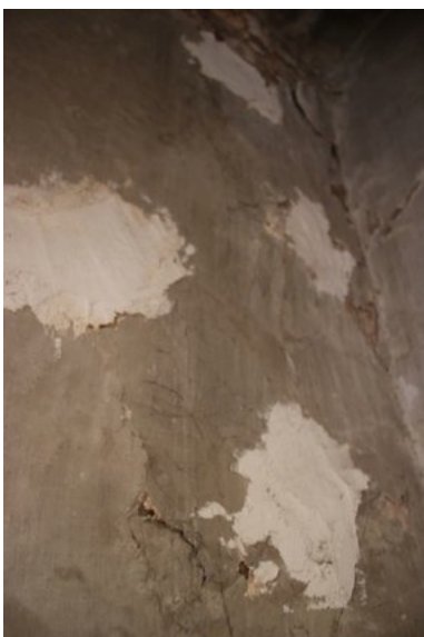
Recull d'imatges que exemplifiquen el pèssim estat de conservació que presenten els revestiments murals i les pintures de la cuina-menjador i les habitacions de la primera planta.
