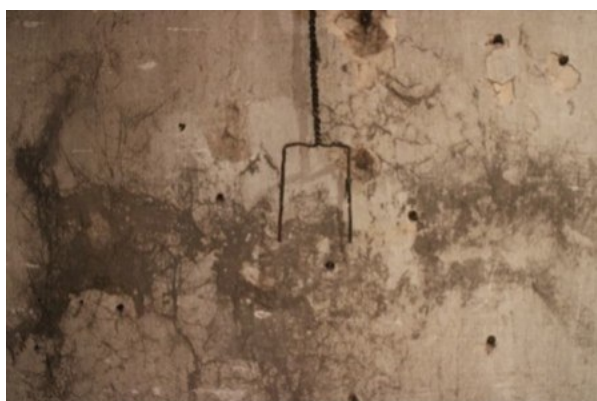
Detall de la brutícia endurida damunt la capa pictòrica a les parets del menjador.
