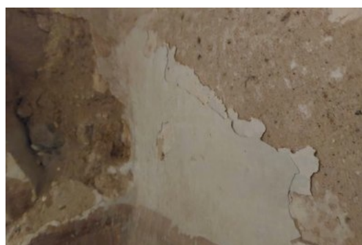
Dos exemples de pèrdua de pintura per aixecament de les capes pictòriques.
