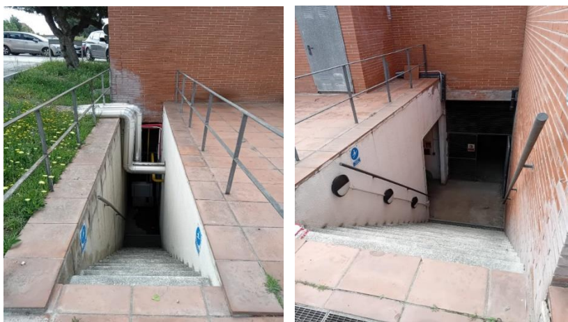
Il·lustració 7: Escala esquerra i escala dreta d'accés a l'edifici J
