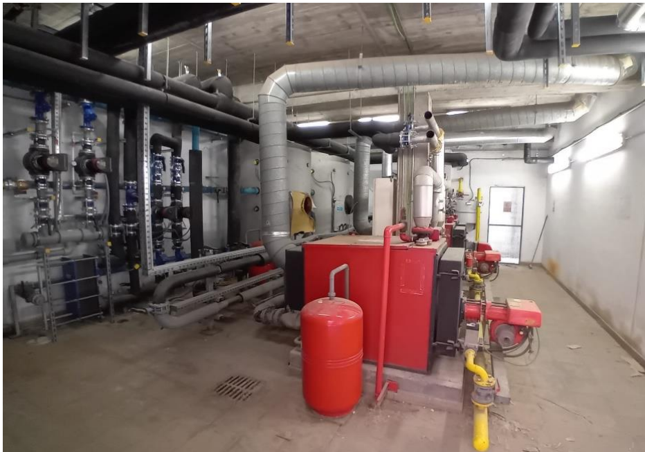
Il·lustració 3: Interior de l'edifici J
