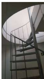
Accés a coberta
