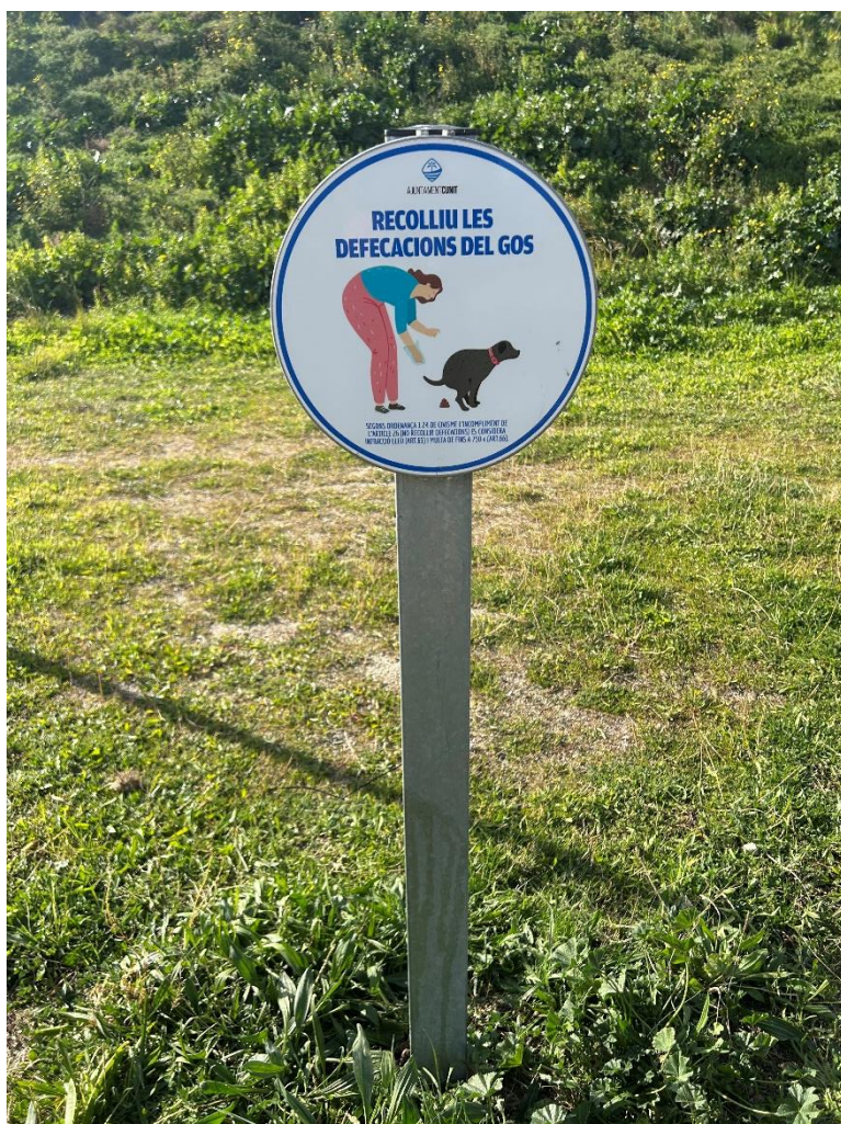
Imatge num 28. Detall d'una senyal informativa de placa d'alumini i suport de secció rectangular d'acer galvanitzat
