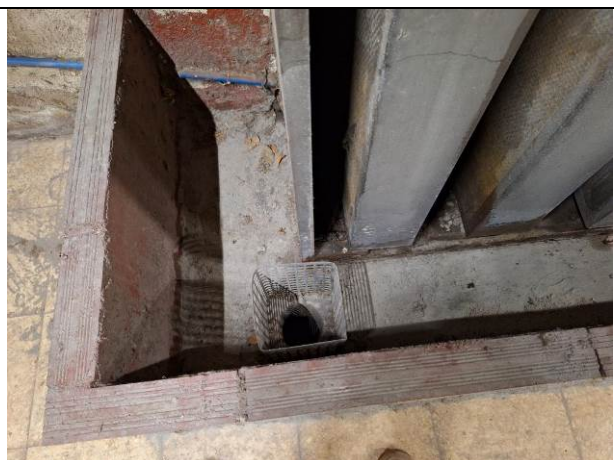
14. Interior del PV
