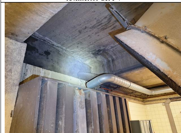
15. Impermeabilització i drenatge existent
