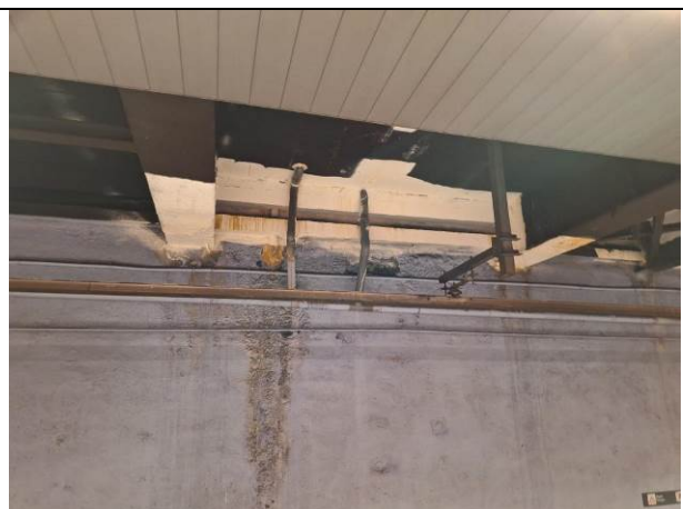
8.Drenatges i filtracions sota PVE
