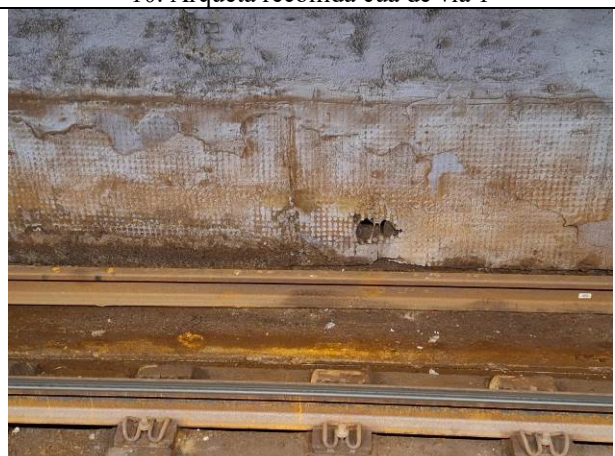
12.Drenatge en sòcol capçalera via 1
