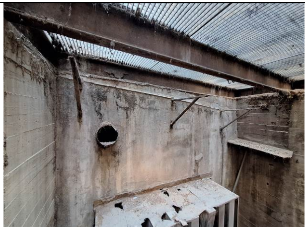
16. Filtres i deteriorament de la cornisa exterior
