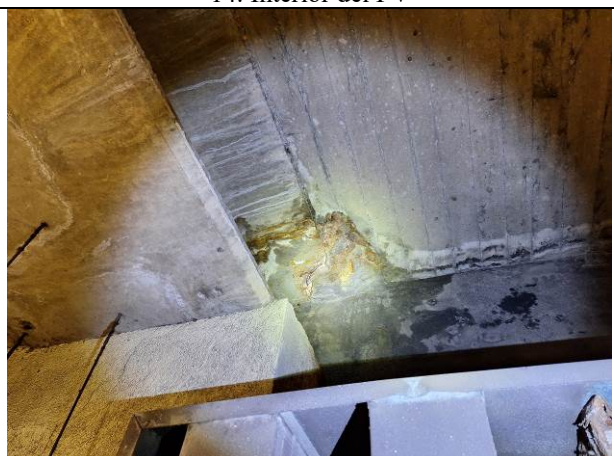
16. Filtres i deteriorament de la cornisa exterior
