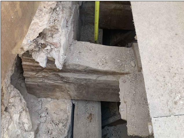
F.11_Cap de biga i durmiente_Foto rehabilitació coberta Fase III
