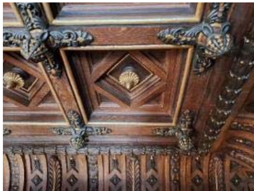
Figura 14. Mòdul constituent d'enteixinat tipus cassetó amb floró central i pinyes a les interseccions.
