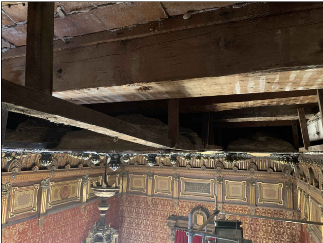
F.09_Estructura de Fusta_Enteixinat Sala de Plens
