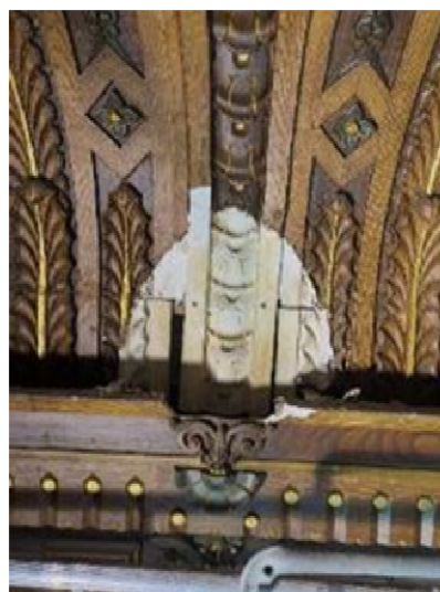
Figura 25. Detall escòcia sense policromia darrera l'antefixe.
