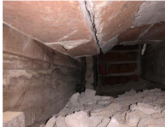
Figura 7. Afectació en estructura de sostre sala de plens. Figura 8. Afectació en entrebigat de sostre sala de plens.
