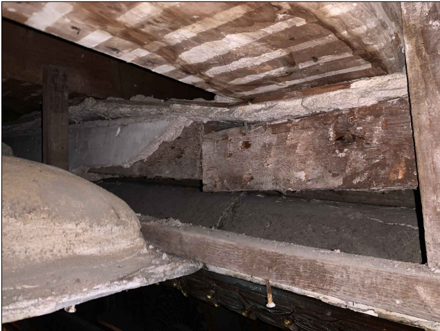
F.07_Llates suport casetons_Enteixinat Sala de Plens
