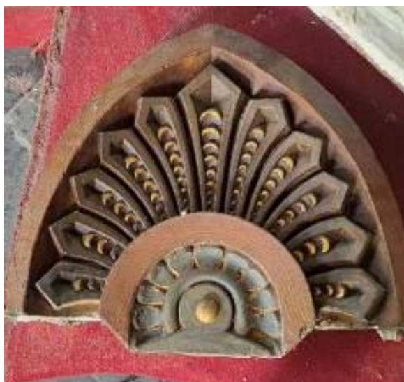
Figura 24. Detall antefixe superposat a la cornisa.
