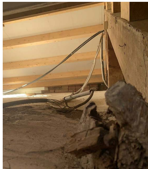
Figura 6. Actuació en coberta
