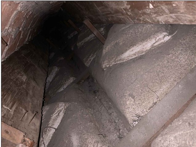
F.08_Bigues de suport de les llates_Enteixinat Sala de Plens
