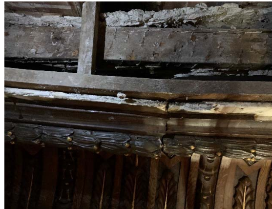
Figura 10. Afectació en enteixinat.
