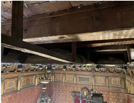
Figura 9. Afectació en enteixinat.
