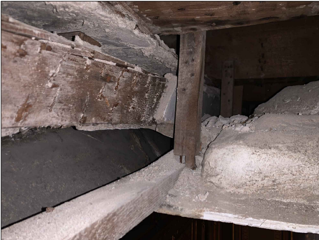
F.06_Llates suport casetons_Enteixinat Sala de Plens
