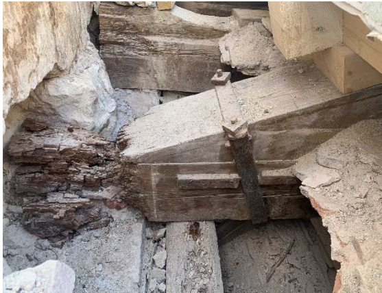
Figura 7. Afectació en estructura de sostre sala de plens. Figura 8. Afectació en entrebigat de sostre sala de plens.
