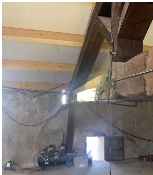
Figura 5. Actuació en coberta.
