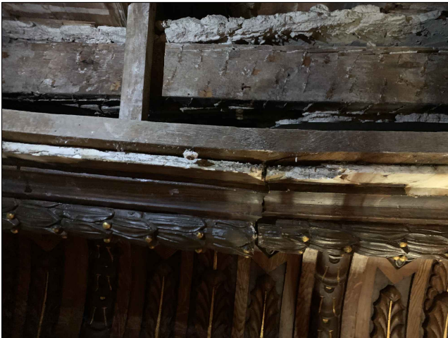
F.03_Esquerda_Enteixinat Sala de Plens
