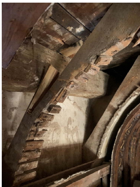
Figura 20. Conjunt de subestructura de suport de les escòcies
