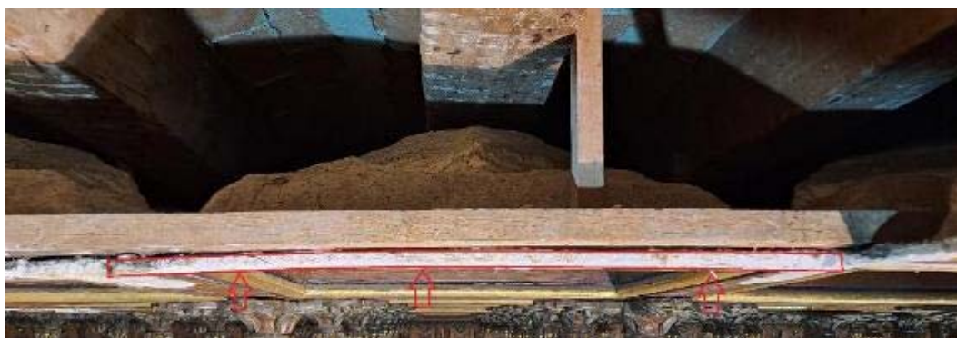
Figura 19. Fixació mecànica del mòdul de cassetó d'escaiola a la subestructura de llates de fusta.
