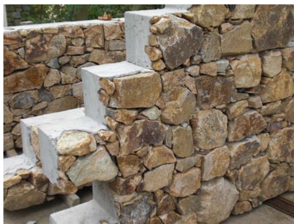
Detall de mur de bloc amb aplacat de pedra natural
