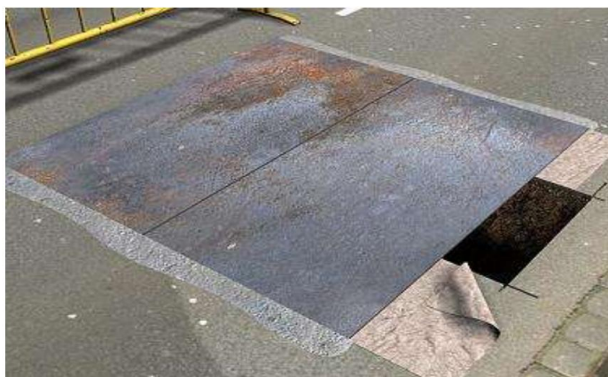
Figura 3. Plataforma de pas de vehicles sobre rases.
