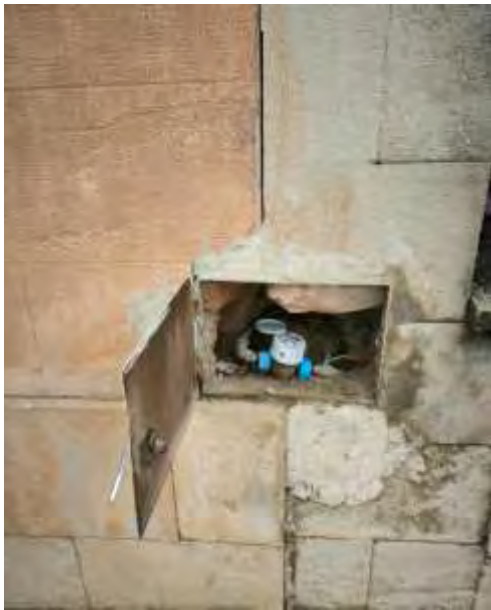
Caixa amb comptador a l'interior, Arnau de Ponç nº 40
