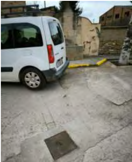
Comptador en pericó al terra a Font d'aigua al carrer del Progrés
