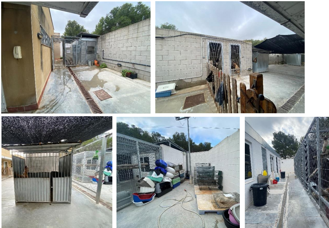
Vistes de la falta d'espai d'emmagatzematge i la incompatibilitat d'usos entre gossos i gats.
