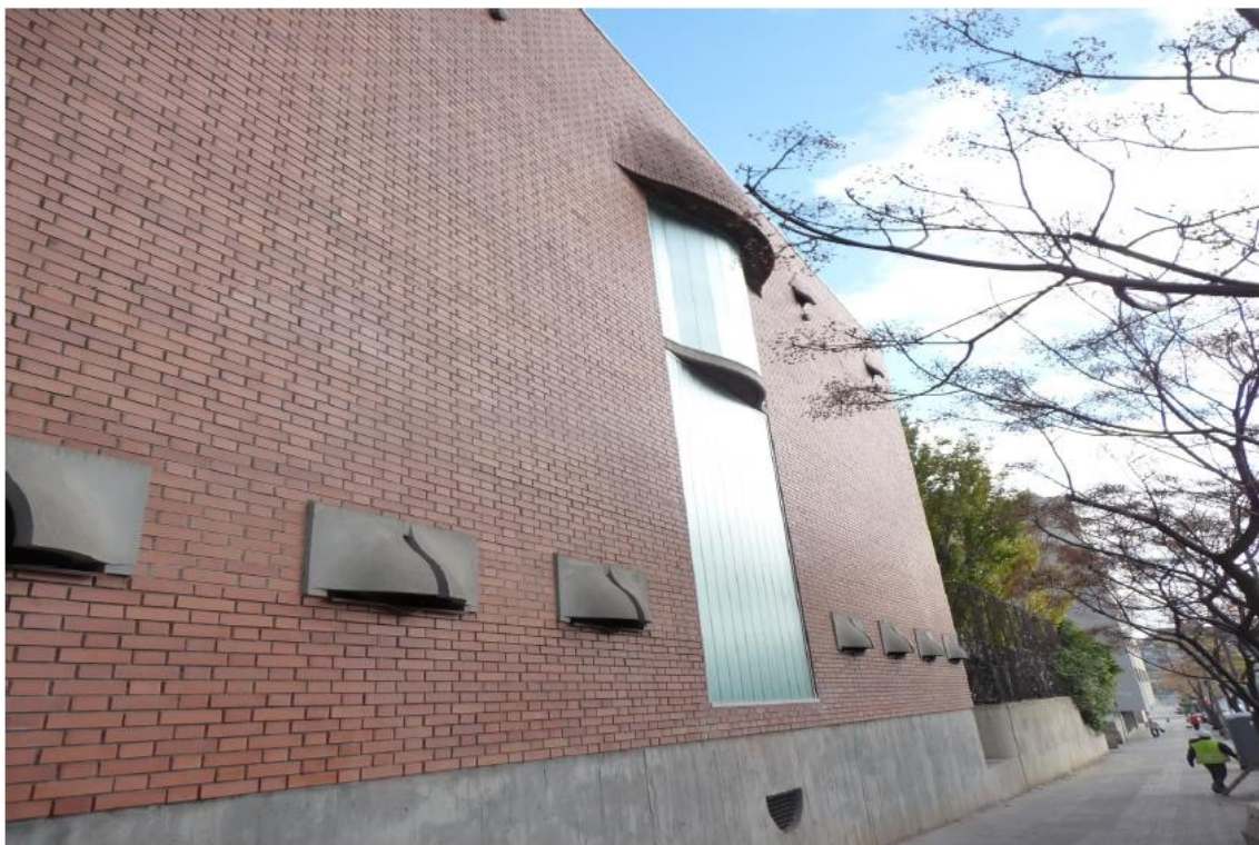
Façana lateral a oest
