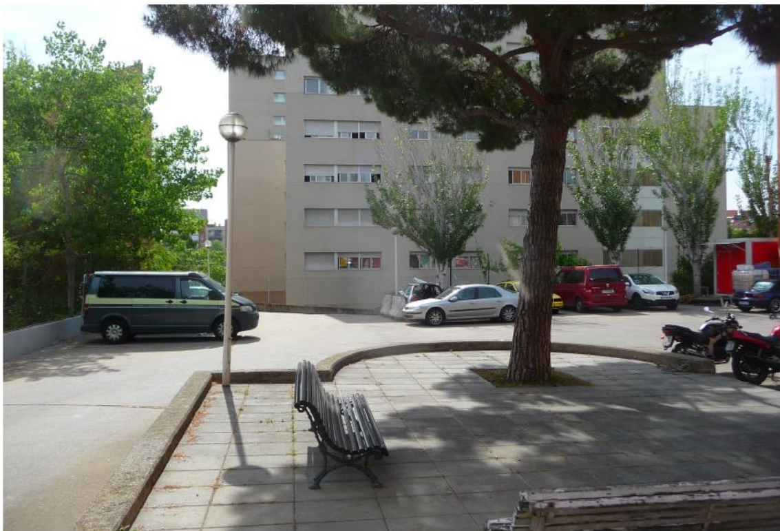
Vista de l'accés al pati posterior per la rampa
