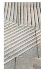
PAVIMENTÀCTIL indicador direccional DE FAÇANA A PAS DE VIANANTS
