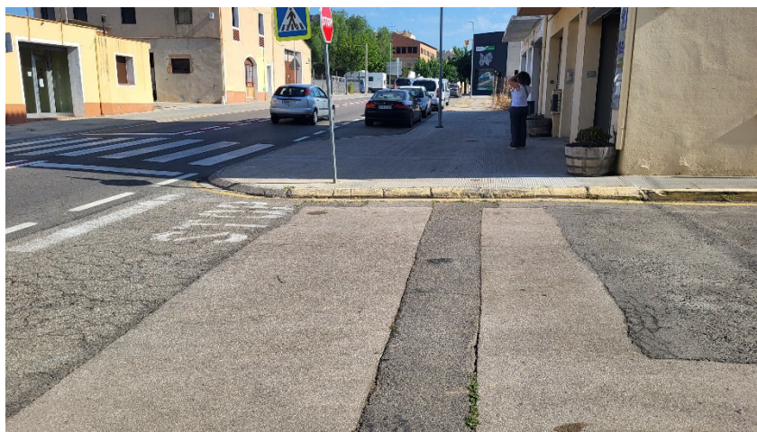
FOTOS 21 – Vista al nord del pas de vianants intersecció amb Carrer del Forn d'Obra
