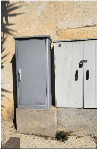
FOTO 1 – Quadres d'enllumenat i baixa tensió junt a E.T.
