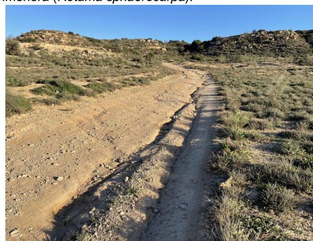
Camins en mal estat al voltant del Mas de Melons.
