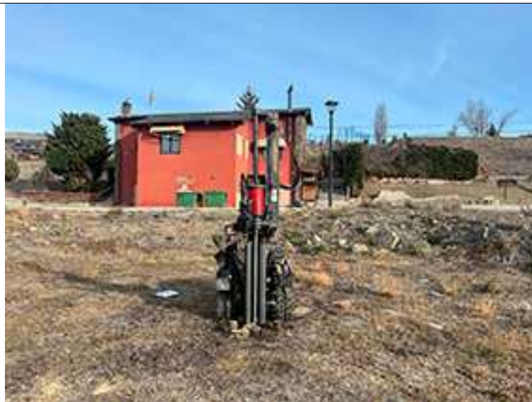
Foto 7: Situació i execució assaig P1.1371-24
