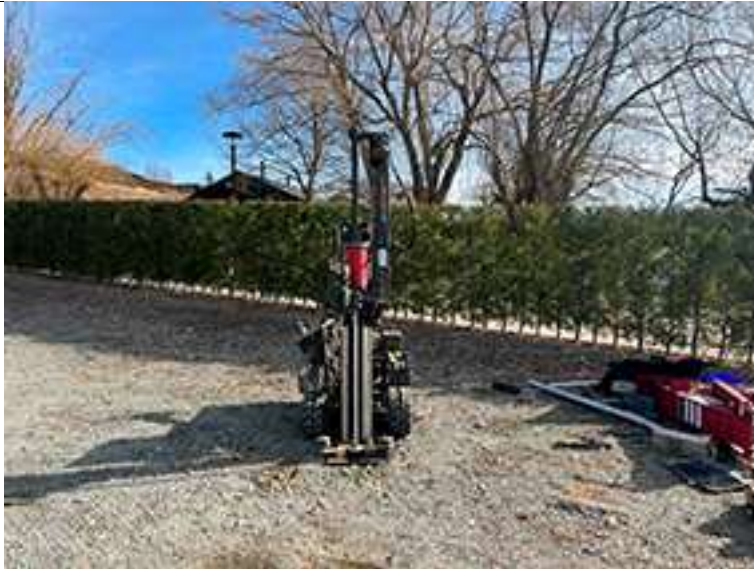
Foto 9: Situació i execució assaig P3.1371-24
