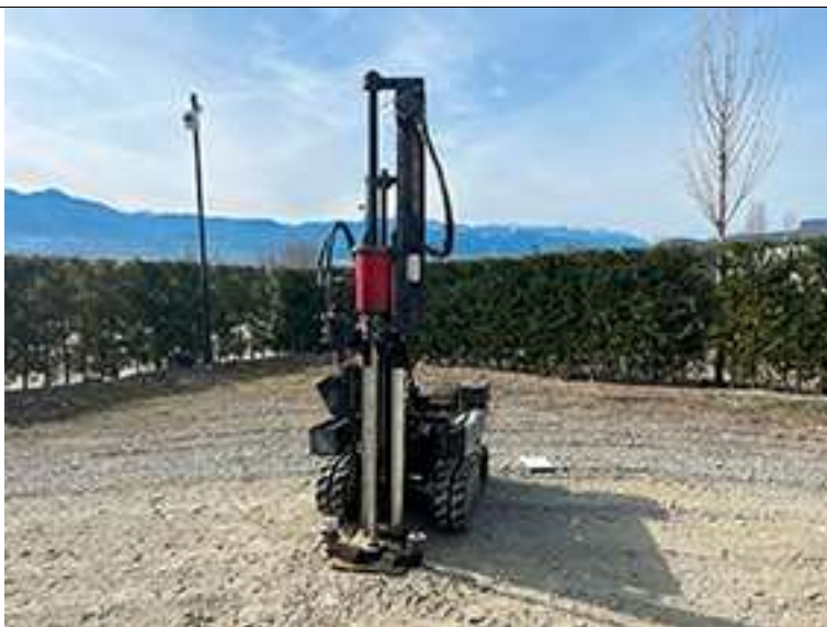
Foto 10: Situació i execució assaig P4.1371-24
