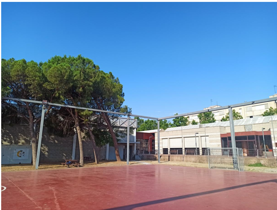
Fotografia 2 Visita general de l'estructura pista poliesportiva.
