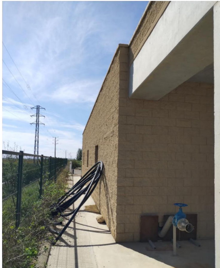
Figura 3. Vista posterior de l'edificació.
