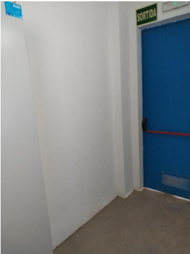
Figura 8. Possible zona col·locació inversors interior.
