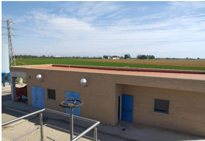
Figura 5. Coberta plana de l'edificació.
