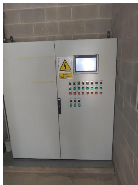
Figura 9. Interior de la caseta, on es destinarà la zona tècnica de la instal·lació fotovoltaica. (2)
