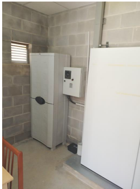
Figura 8. Interior de la caseta, on es destinarà la zona tècnica de la instal·lació fotovoltaica. (1)
