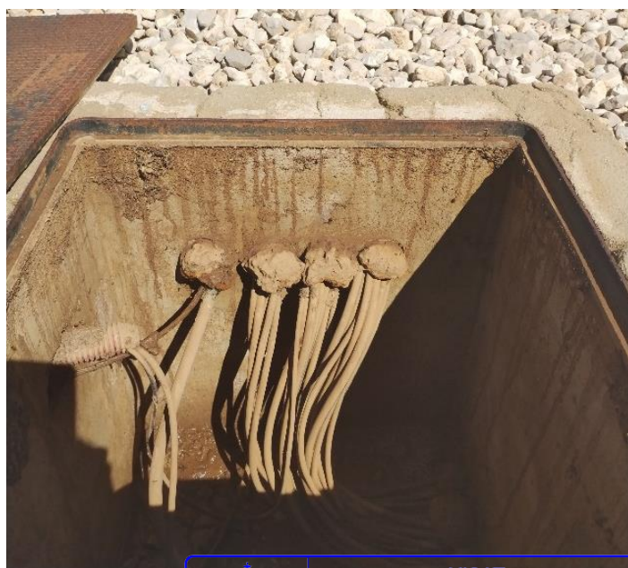
Figura 6. Interior de l'arqueta en detall.
