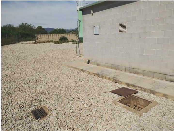
Figura 4. Ubicació de la caseta, on es destinarà la zona tècnica, i l'arqueta que s'utilitzarà pels conductors del camp fotovoltaic a aquesta.
