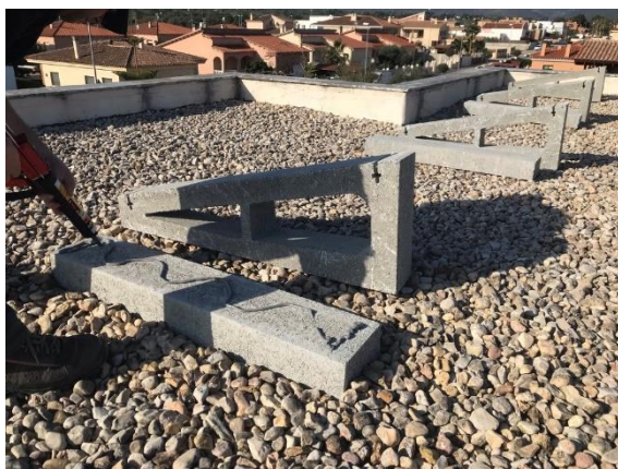
Figura 13. Elements estructura estàtica de suport.
