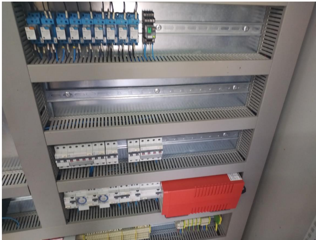
Figura 11. Espai al QGD on es disposaran les proteccions de la instal·lació fotovoltaica.
