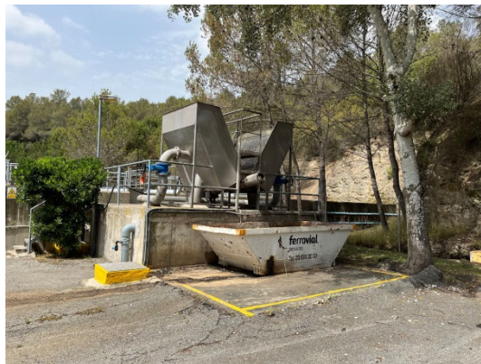
Foto Núm. 2 Vista tamís de fins del pretractament
