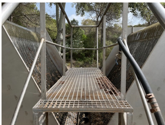
Foto Núm. 3 Detall tramex del tamís de fins a canviar
