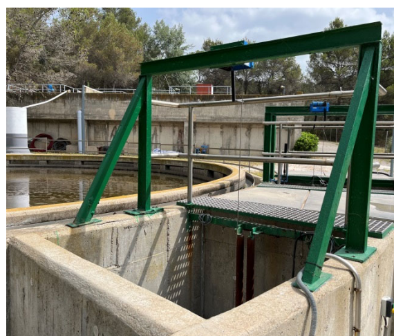
Figura núm.4: Tubs guia i estructura suport de l'arqueta de flotants
