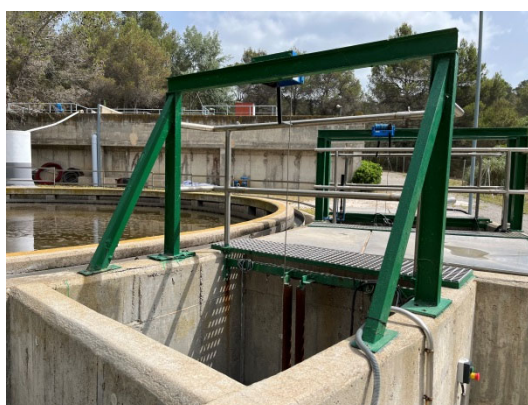
Foto Núm. 8 Detall pòrtic a canviar en l'arqueta de flotants
