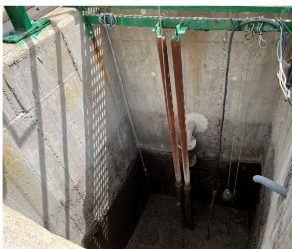
Figura núm.4: Tubs guia i estructura suport de l'arqueta de flotants
