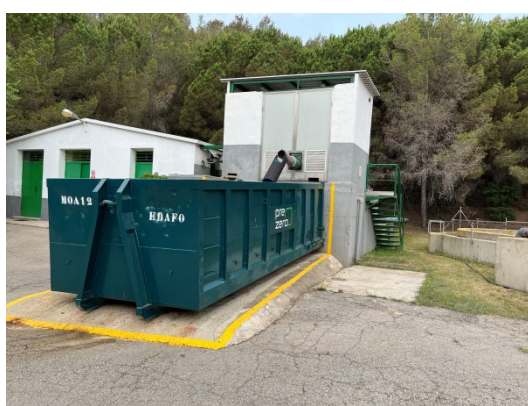
Foto Núm. 10 Vista exterior de la sala de deshidratació
