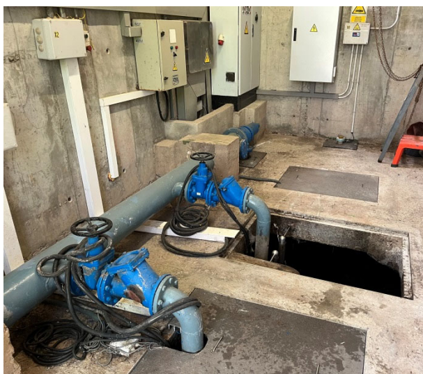
Figura núm.7: Interior EB la Betzuca i arqueta bomba Sulzer
