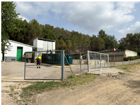
Foto Núm. 1 Vista general de l'EDAR Matadepera
