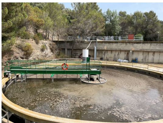
Foto Núm. 5 Vista del decantador secundari
