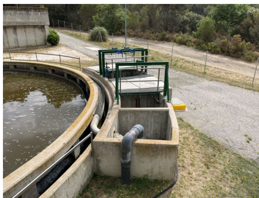
Foto Núm. 6 Vista de les arquetes annexes al decantador secundari
