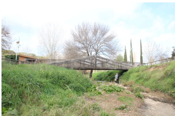
Imatge 1: Passarel·la actual
