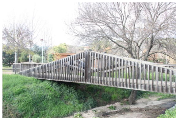
Imatge 2: Passarel·la actual
