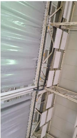
Figura 15. Continuació de l'interior
