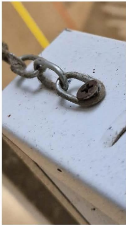
Figura 12. Connexió de les cadenes a les plaques
