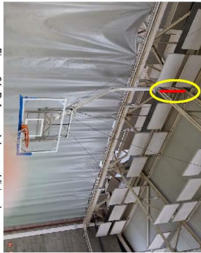
Figura 61. Reforç amb barra addicional
