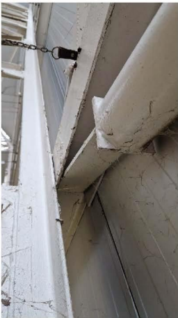
Figura 56. Plina de reforç de les diagonals de rigidització
