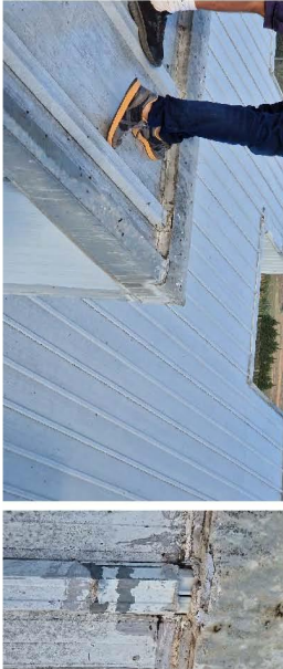
Figura 20. Tapajunts dels panells no fixats
