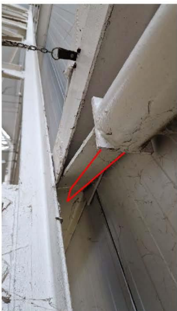
Figura 63. Rigidització de platina extrema
