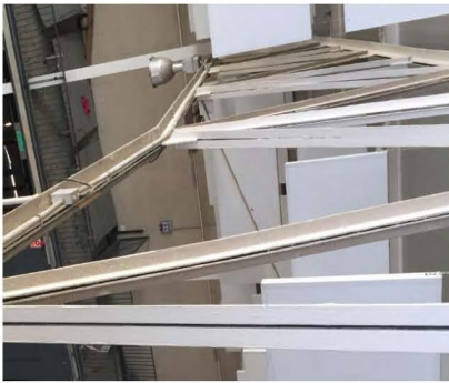
Figura 28. Perfils en L en contacte i sense platines d'unió
