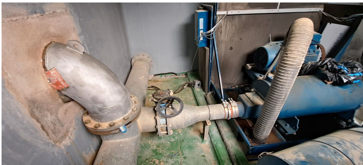
Foto Núm 2: Vista de la canonada de sortida a substituir
