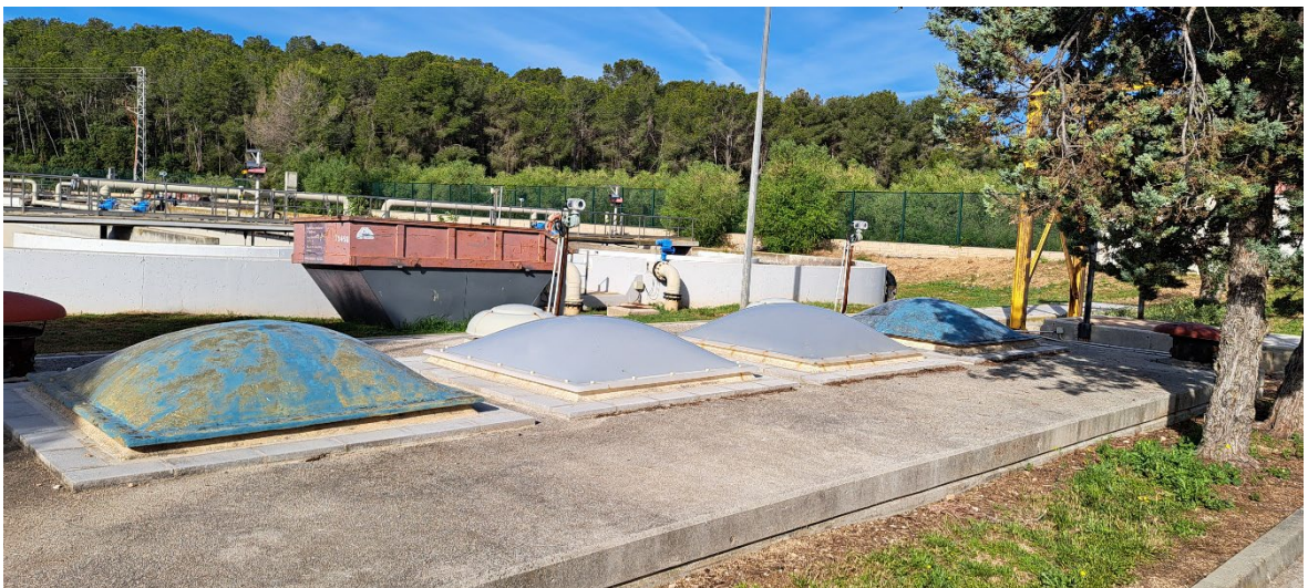
Foto Núm 11: Vista propera de les claraboies actuals de la sala de bufants
