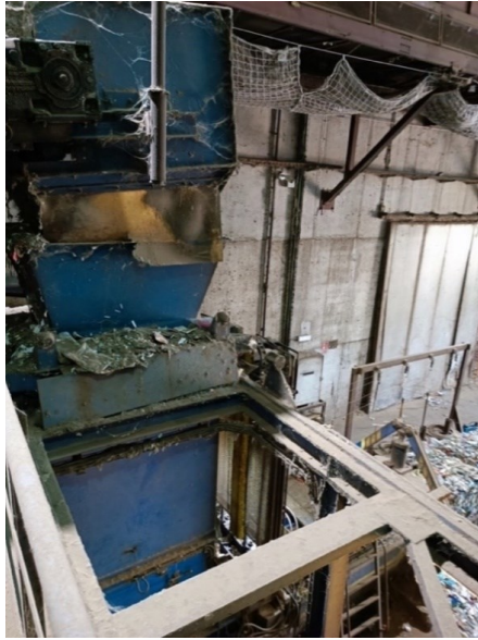
Figura 15. Vistes laterals de la cinta i la tremuja d'alimentació de la premsa multi-material n°1.
