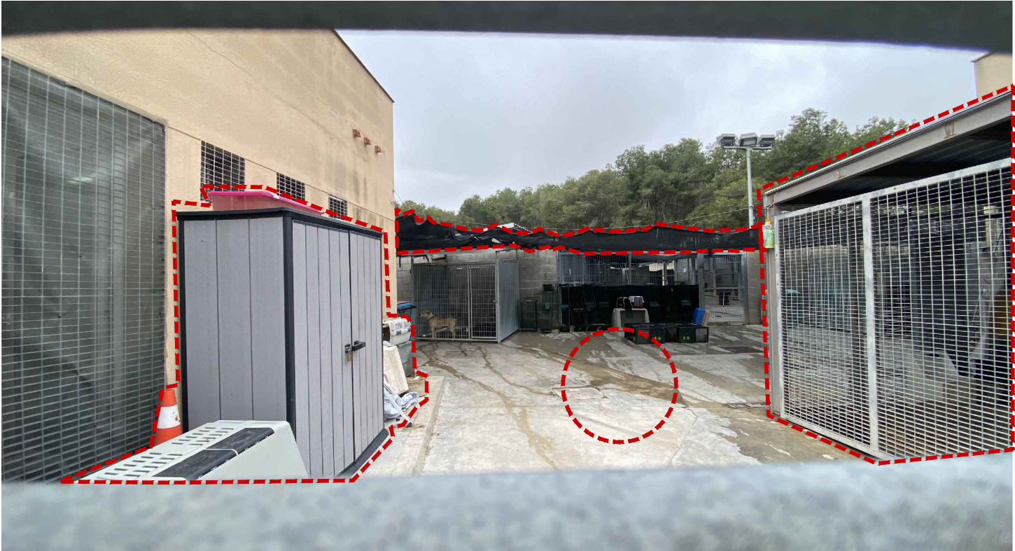
V1. Mobiliari exterior temporal. Manca d'emmagatzematge. Tendals d'ombreig en mal estat. Paviment no drenant i sistema de drenatge insuficient. Gàbies temporals per sobrepoblació canina. Font: GAA 17/06/24
