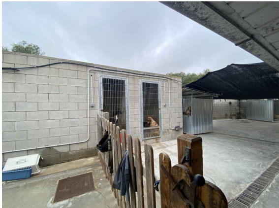
V7. TANQUES DE FUSTA EXTERIORS Font: GAA 17/06/24
