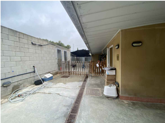
V8. PAS CENTRAL EXTERIOR. DESAIGUES Font: GAA 17/06/24
