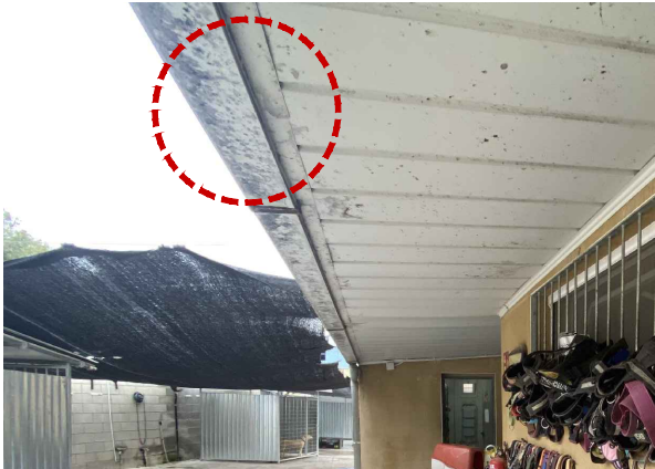
V6. Coberts exteriors amb pintura bufada Font: GAA 17/06/24
