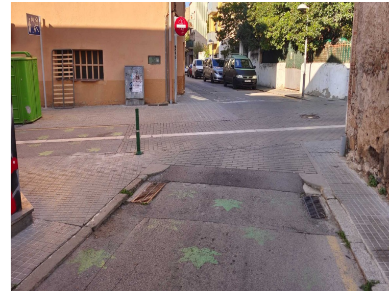
Figura 7. Vista de l'accés del carrer Lluïsa Oller des del carrer Montseny
