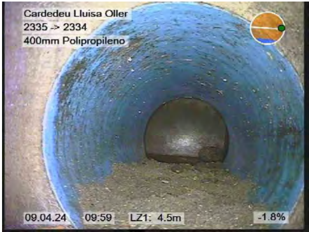
27.jpg, 00:01:07, 4.50m FINAL DE LA INSPECCION
