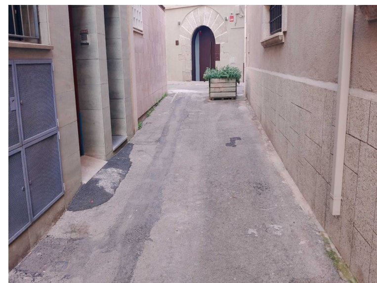
Figura 12. Vista del tram alt del carrer del Pou.
