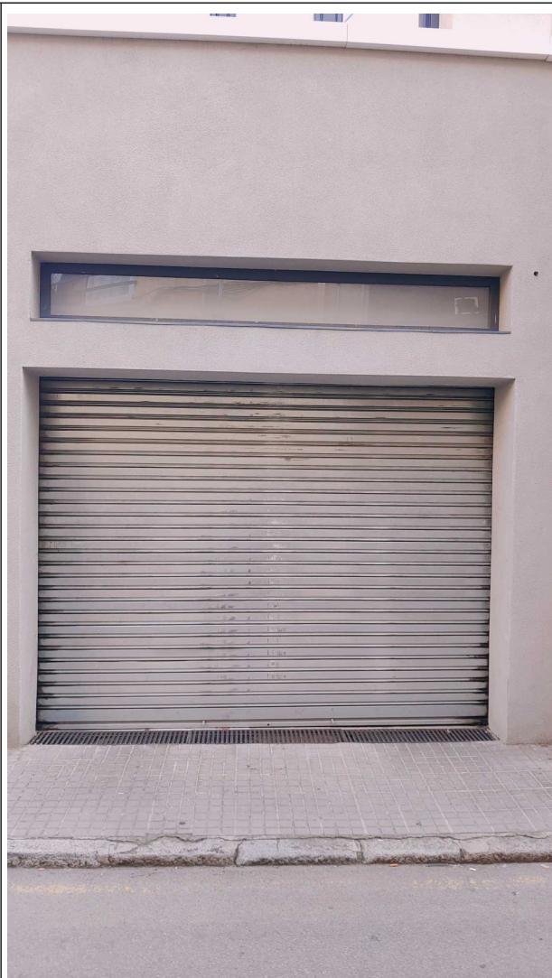
Accés des del carrer Lluïsa oller del Carrer del Pou Núm.15
