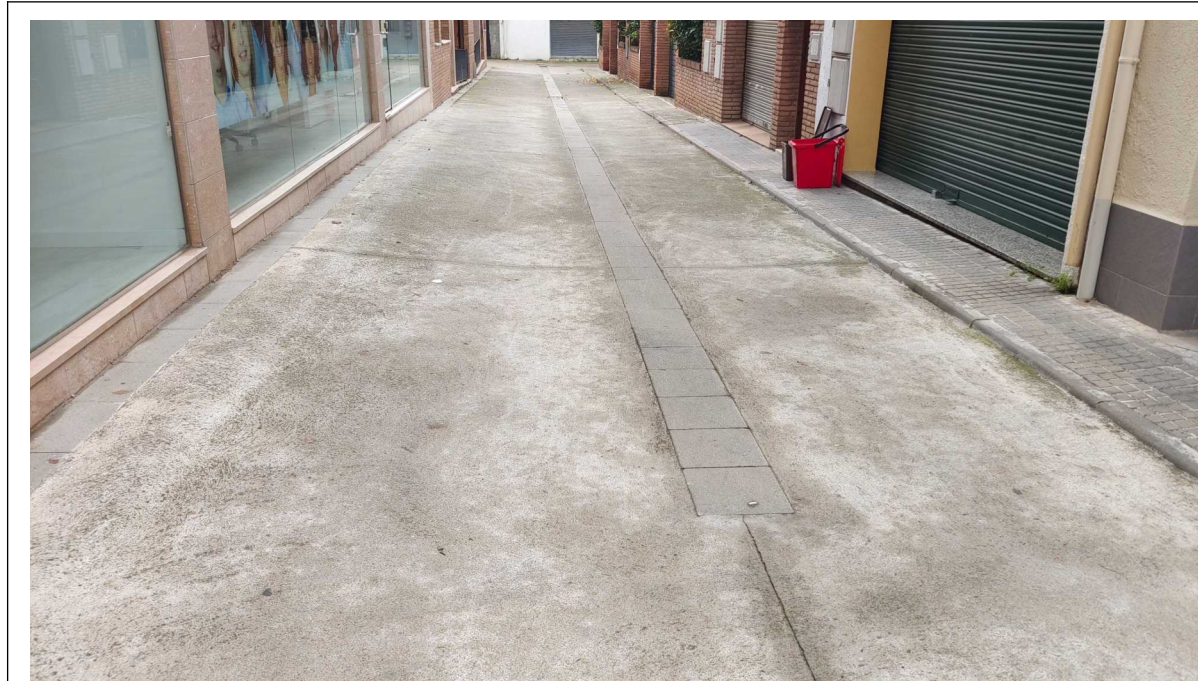
Foto exemple del paviment actual al carrer Sant Eloi
