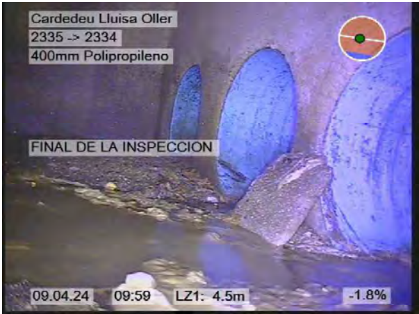
26.jpg, 00:01:07, 4.50m FINAL DE LA INSPECCION
