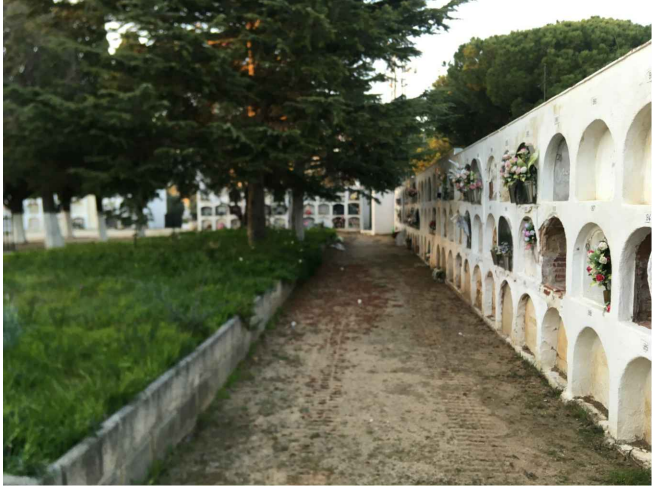
Zona de construcció de banc i adequació de paviment
