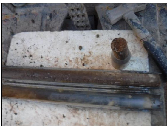
Foto 9: Sondage S-3, SPT a 0,8 metres.
