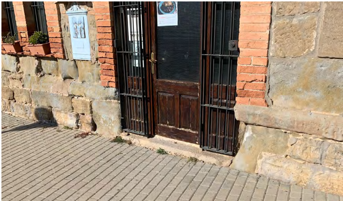
Àmbit a realitzar la intervenció de reparació de façana
