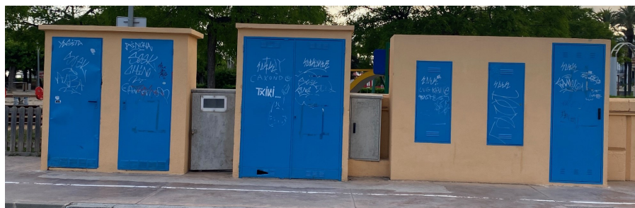
Construcció de paret posterior dels armaris un cop enderrocat el mur de formigó
