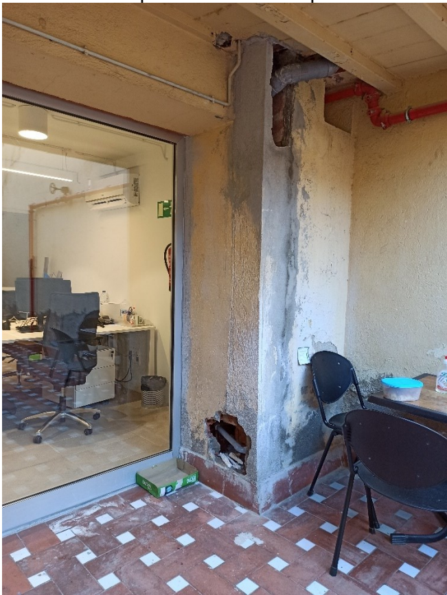
Patologies a la planta Baixa de la façana posterior derivades de la presència d'humitat tant per perdues dels elements de les instal·lacions de sanejament, actuacions pel pas de noves xarxes, com per la manca d'estanqueïtat del ràfec de planta Baixa.
