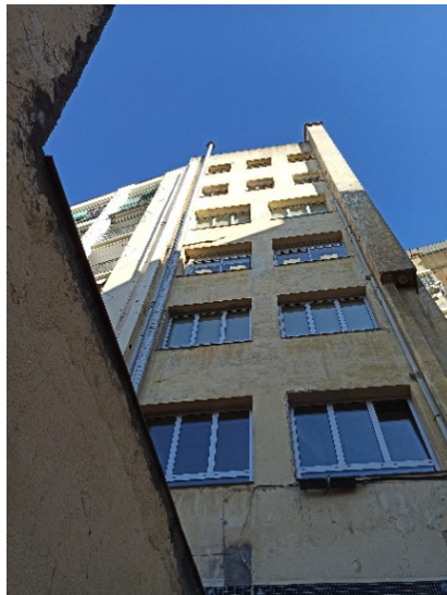
VISTA GENERAL ESTAT ACTUAL FAÇANA
