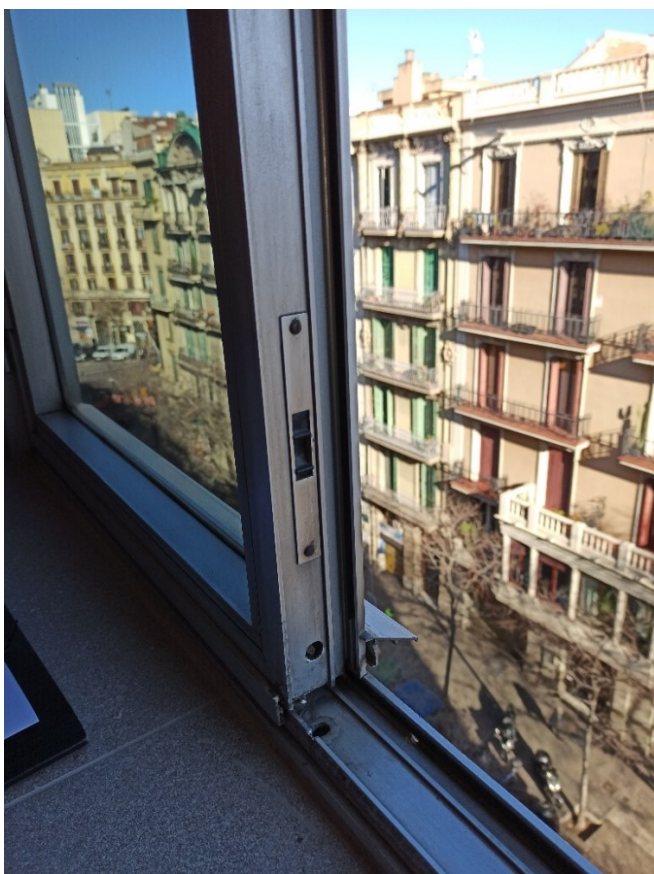
Detall de la perfil·leria del tancament existent, amb un sistema d'estanqueïtat per geometria, sense cap tipus de goma que funcioni com a rivet.
