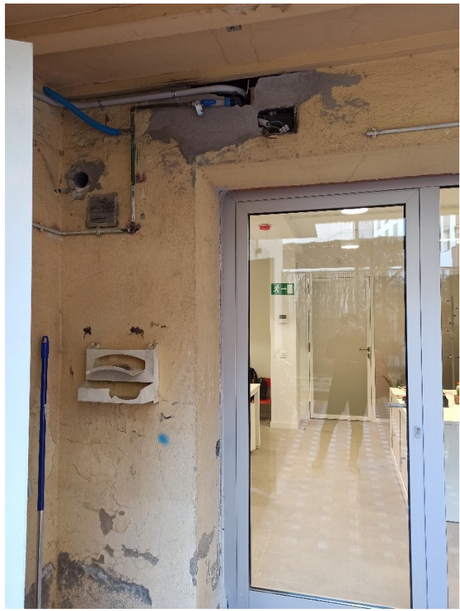
A la fotografia també s'observa, l'estat de la façana posterior on els paraments estucats, mostren fisures i empatsats per les diverses actuacions realitzades al llarg del temps
