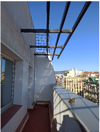
ESTAT ACTUAL FAÇANA RECLADA I PÈRGOLA
