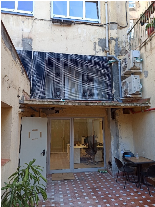
Patologies a la planta Baixa de la façana posterior derivades de la presència d'humitat tant per perdues dels elements de les instal·lacions de sanejament, actuacions pel pas de noves xarxes, com per la manca d'estanqueïtat del ràfec de planta Baixa.
