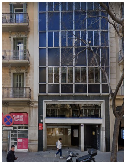
VISTA GENERAL ESTAT ACTUAL FAÇANA
