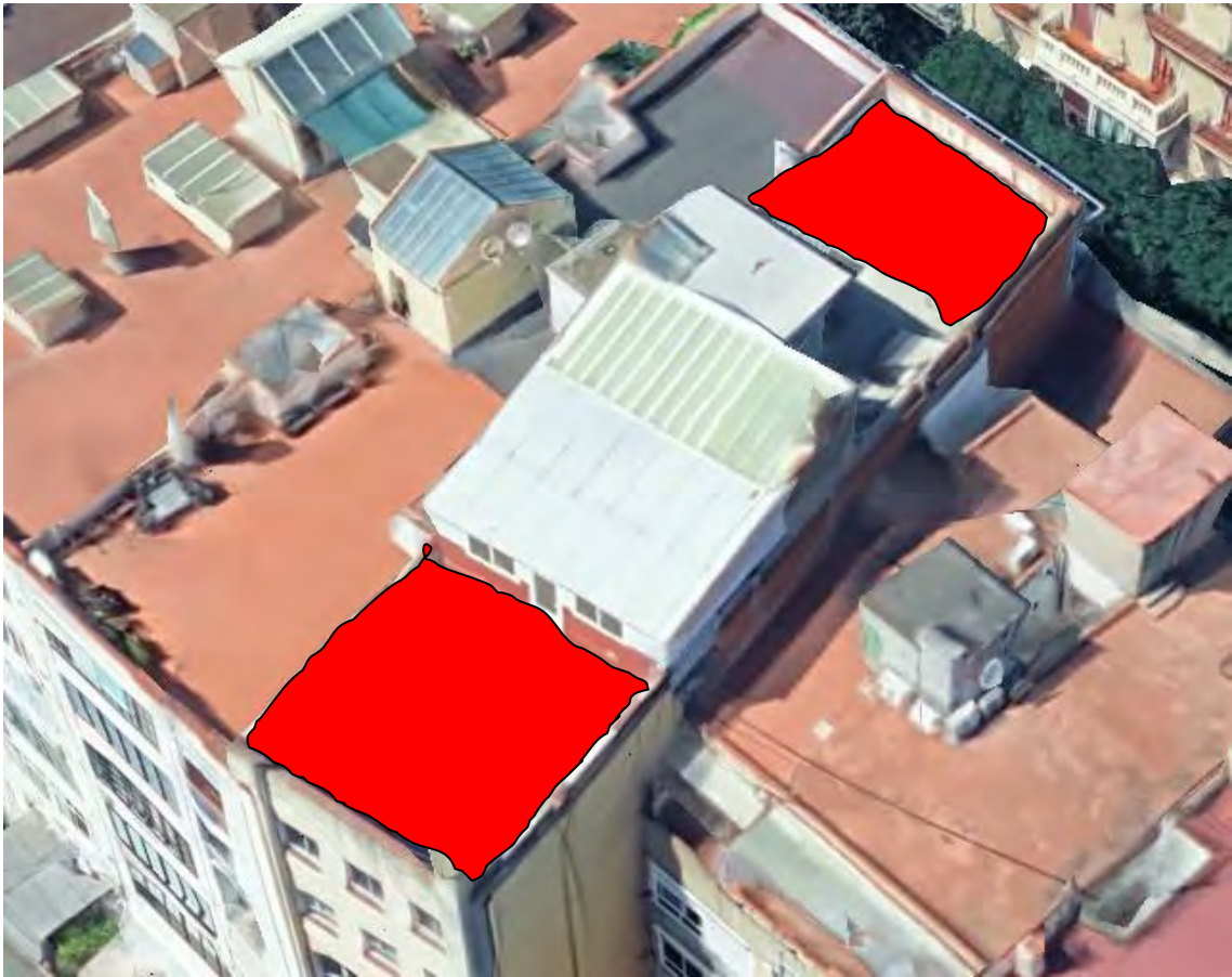
Zona ubicació mòduls fotovoltaïcs
