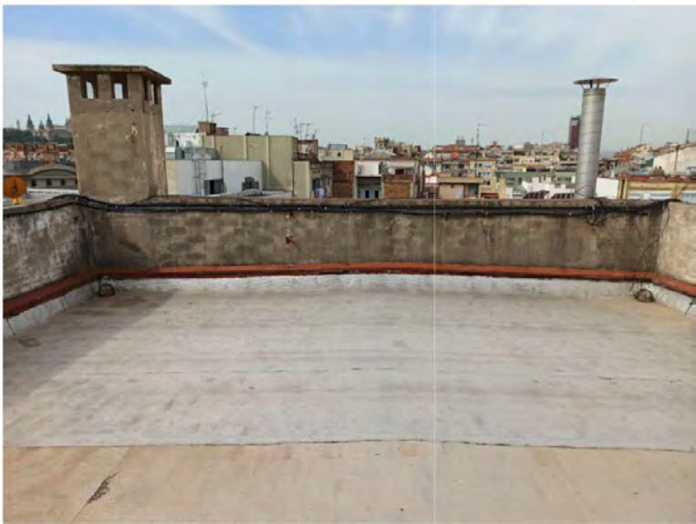
Fotografia actual – Coberta
