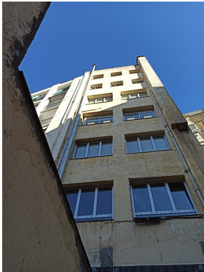
A la fotografia també s'observa, l'estat de la façana posterior on els paraments estucats, mostren fisures i empatsats per les diverses actuacions realitzades al llarg del temps
