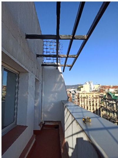
ESTAT ACTUAL FAÇANA RECLADA I PÈRGOLA
