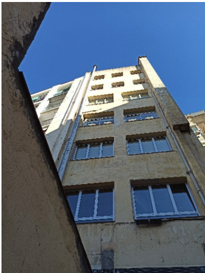
VISTA GENERAL ESTAT ACTUAL FAÇANA
