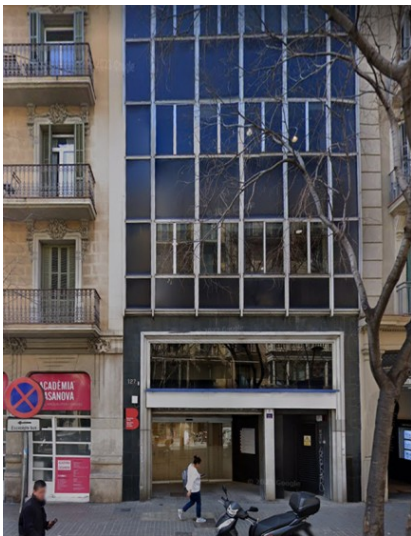
VISTA GENERAL ESTAT ACTUAL FAÇANA
