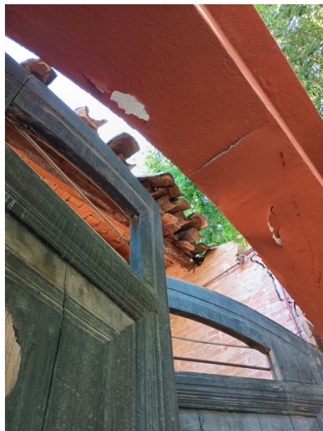
Fotografies 2 i 3. Vistes de les parts de coberta col·lapsades des de la façana sud-est.
