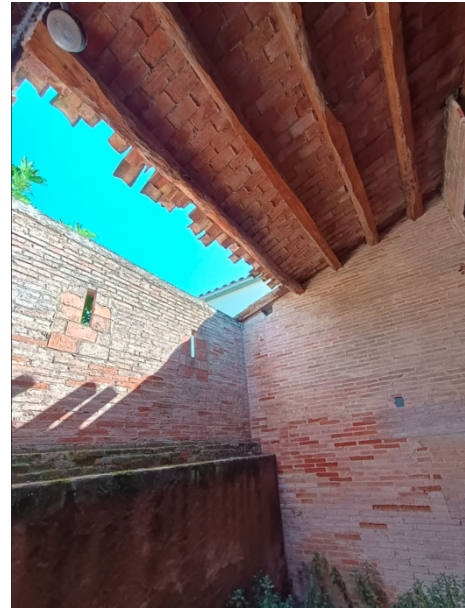
Fotografies 4 i 5. Vistes de les parts de coberta col·lapsades des de la façana nord-oest.
