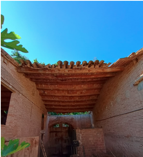
Fotografies 4 i 5. Vistes de les parts de coberta col·lapsades des de la façana nord-oest.
