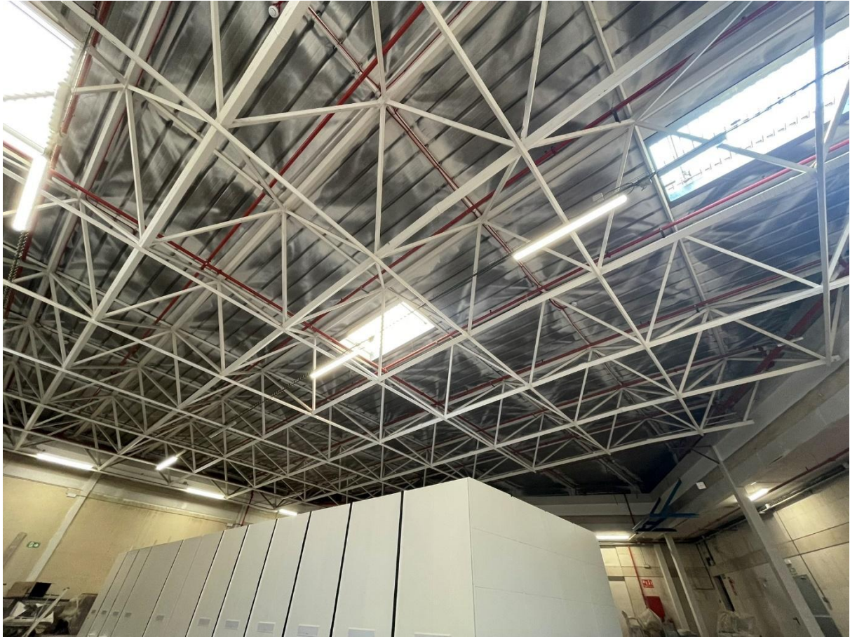
Imatge interior de la coberta en estat actual
