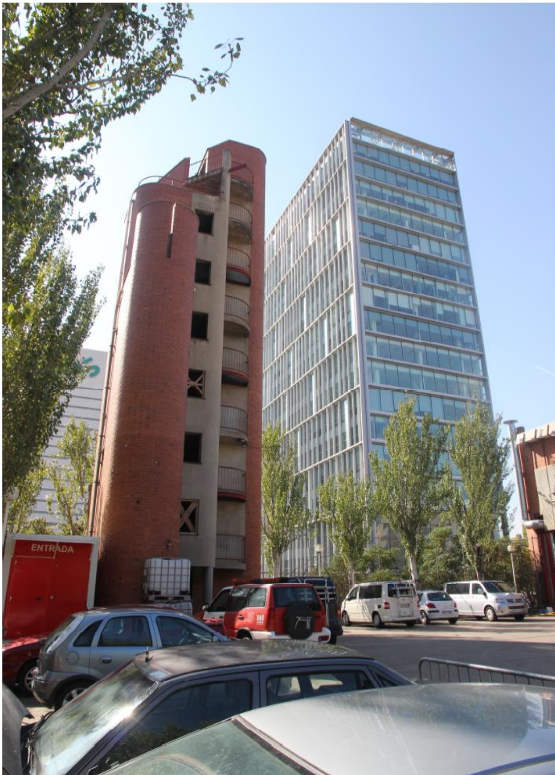
Vista exterior de la torre de pràctiques
