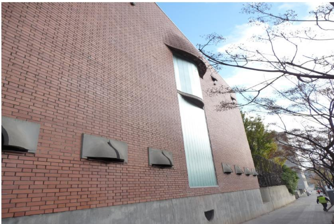
Façana lateral a oest
