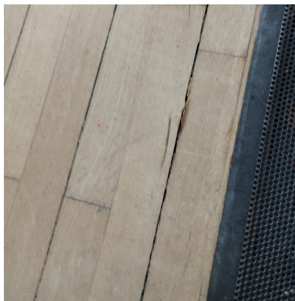
DESPLAÇAMENT PLANIMÈTRIC TARIMA I DESPERFECTES JUNTES LONGITUDINALS
