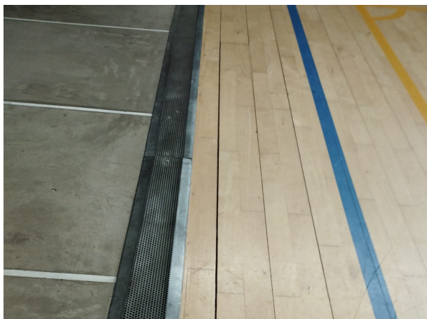
DILATACIONS LONGITUDINALS EN EL PERÍMETRE DE LA TARIMA
