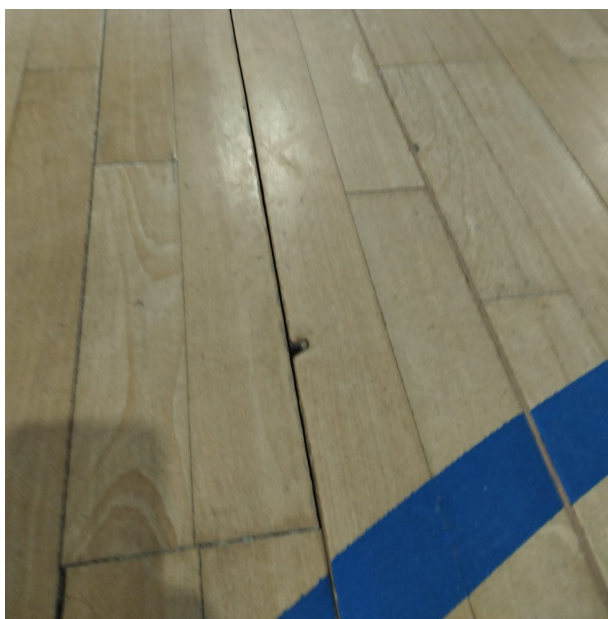
DESPLAÇAMENT PLANIMÈTRIC TARIMA I DESPERFECTES JUNTES LONGITUDINALS
