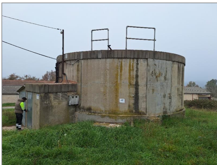
Exterior del dipòsit de Santa Creu
